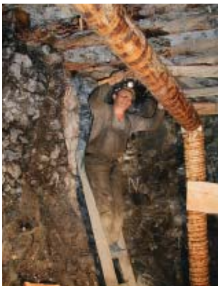
Budování výztuže na dobývce
