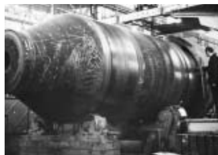
Obr. 5 ?Svařování lisovního válce
