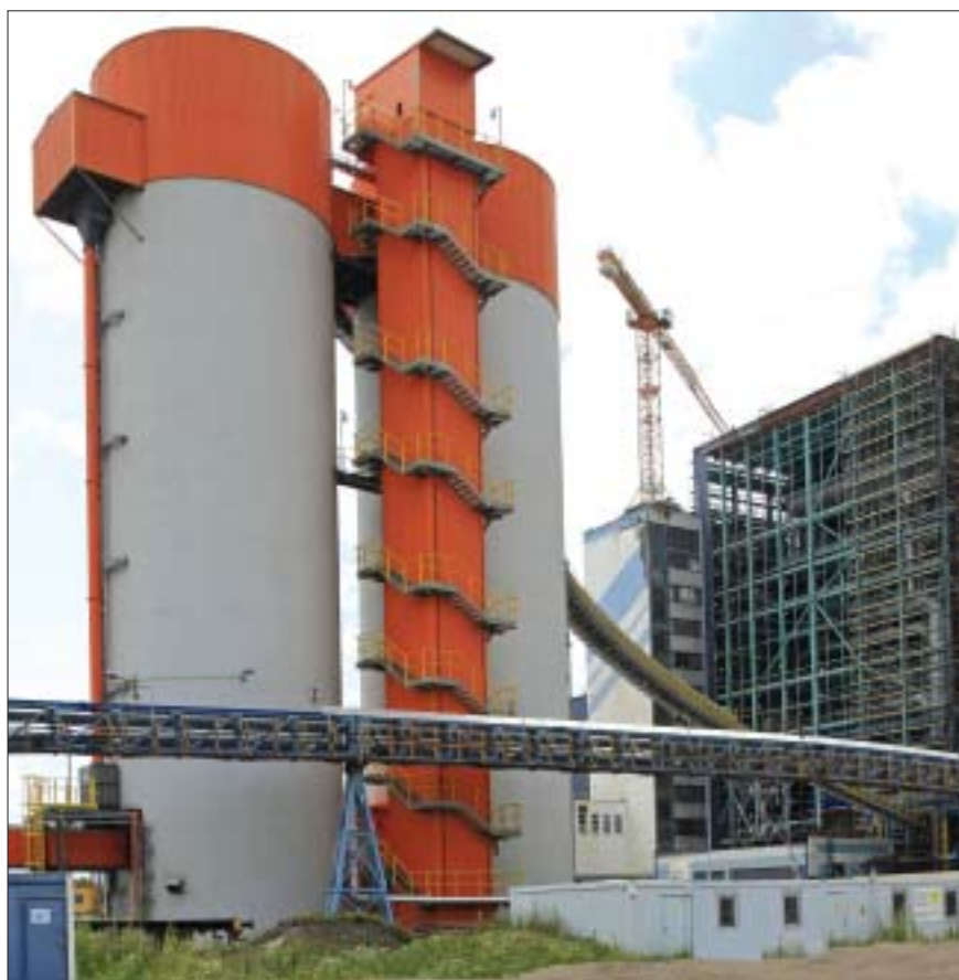
Strusková síla, vpravo demontáž východní fasády
