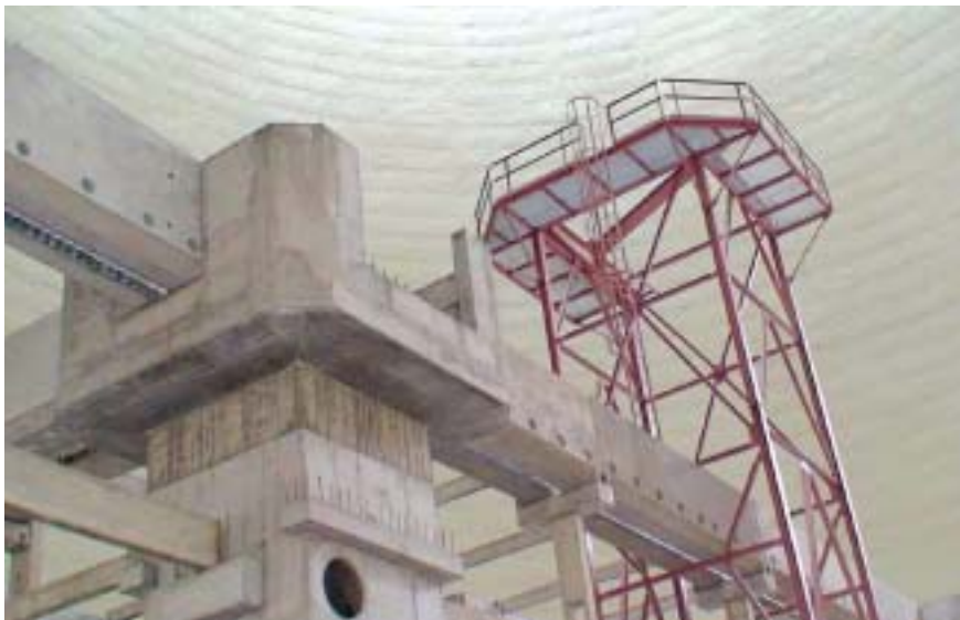
Výtlačný kanál, prefa vestavba a ocelová konstrukce pro kouřovod
