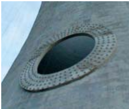
Prostup pro kouřovod v tahové skořepině chladicí věže
