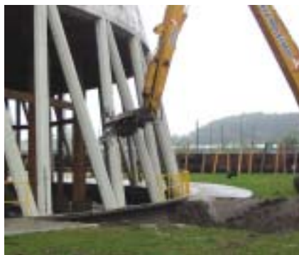
Zahájení demolice Zrůstění páru šikmých konstrukcí
