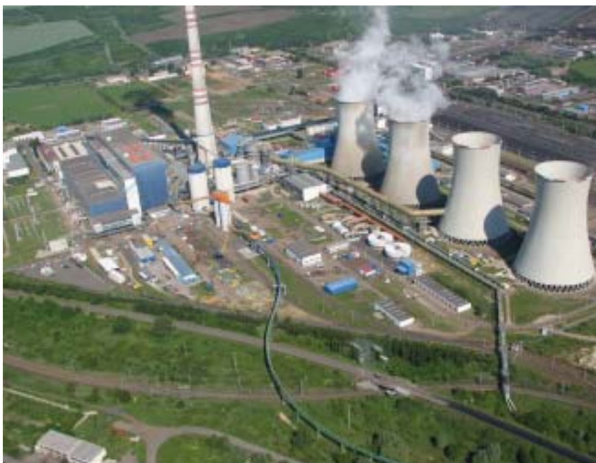
Letecký pohled na rekonstruované věže č. 23 a 24 KO ETU II se zaústěním odsíření do věže 23
