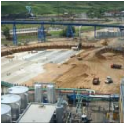
Podkladní betony pod pilotovací rovinu
