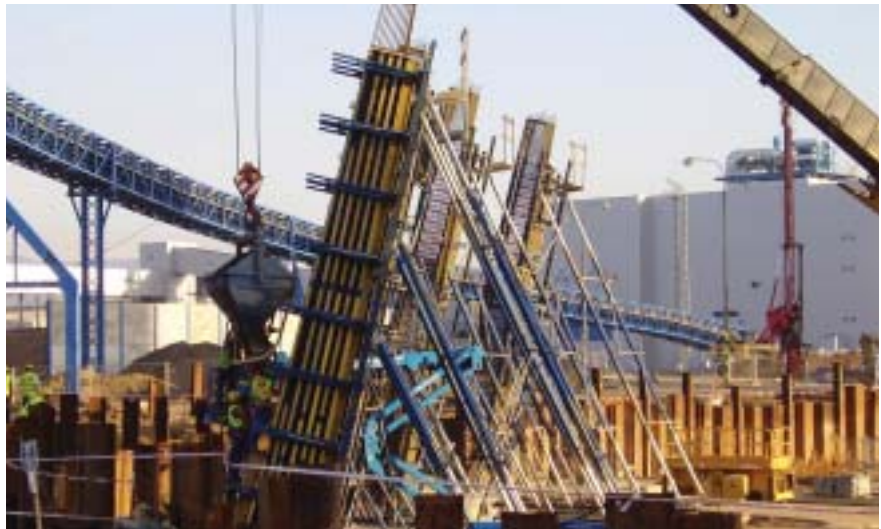
Zahájení realizace šikmých stojek (srpen 2009)
