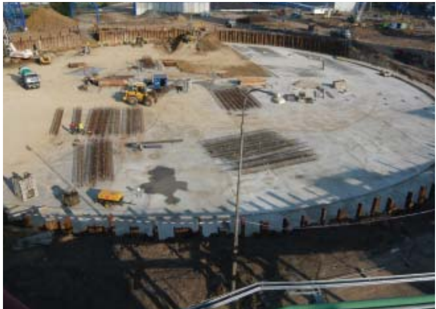
Speciální zakládání (červenec 2009)
