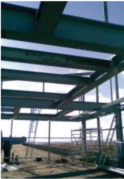
Snímek z montáže ocelových konstrukcí – ilustrační foto
