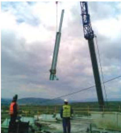
Doprava konstrukčních dílů určených k montáži zastřešení
