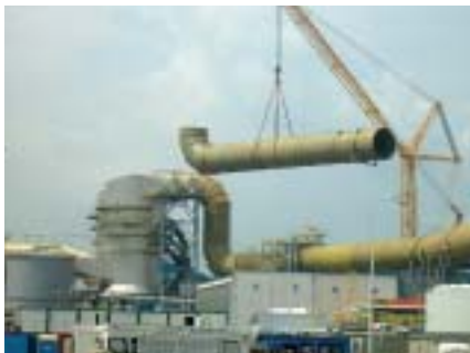
Montáž kouřovodu čistých spalin
