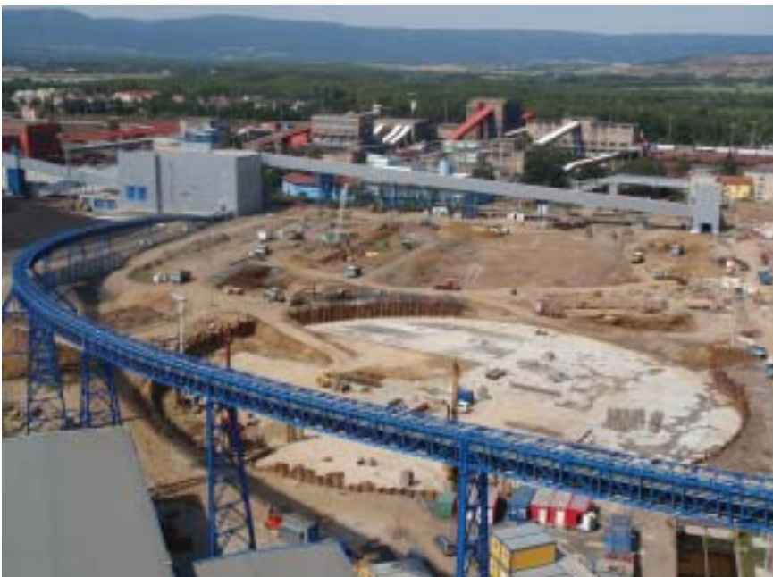
Červenec 2009 – uvolnění staveniště pro chladicí věž
