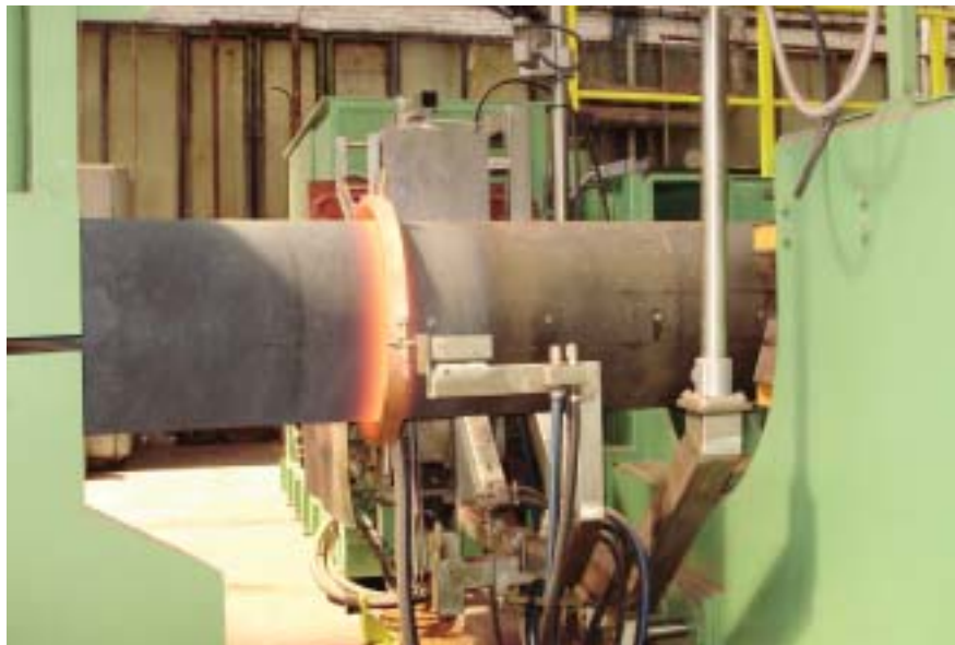
Příprava na ohyb trubky oceli P92
