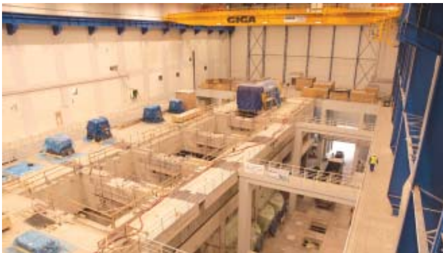
Snímek dokončené stavební připravenosti strojovny (+15,5 m). Dodavatelé technologie byla strojovna předána s osazeným generátorem
