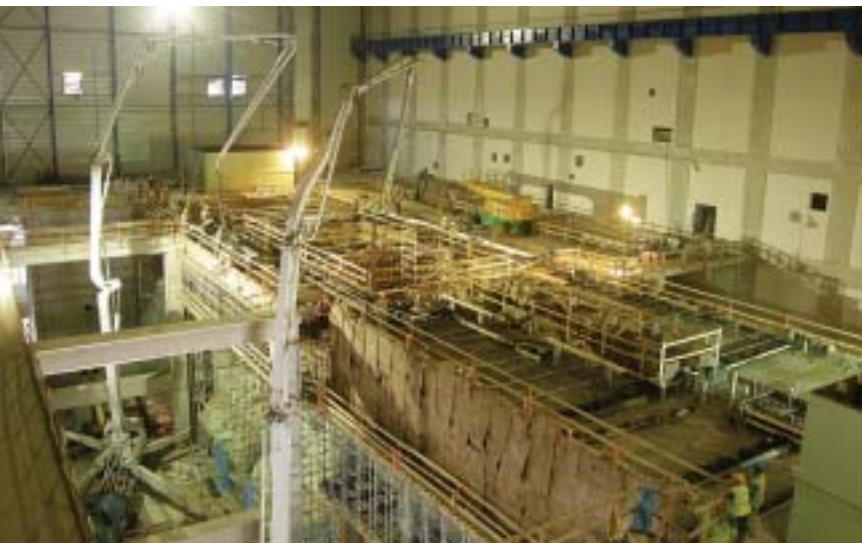
Obrázek průběhu betonáže IV. části TG
