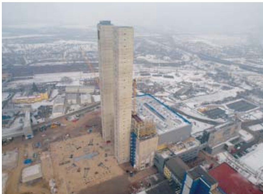
Fotografie na stavební připravenost kotelný pro dodavatele kotle (15. leden 2010)
