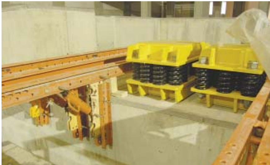
Snímky z osazování pružinových podpěr GERB
