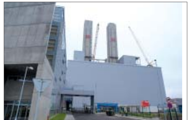
Fotografie postupu opláštění schodiškových věží
