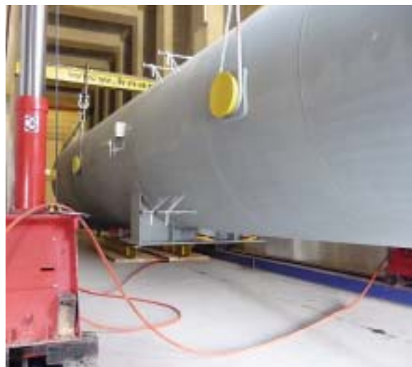
Obrázek přesunu napájecí nádrže pomocí LIFT SYSTÉMU na úrovni + 21,4 m
