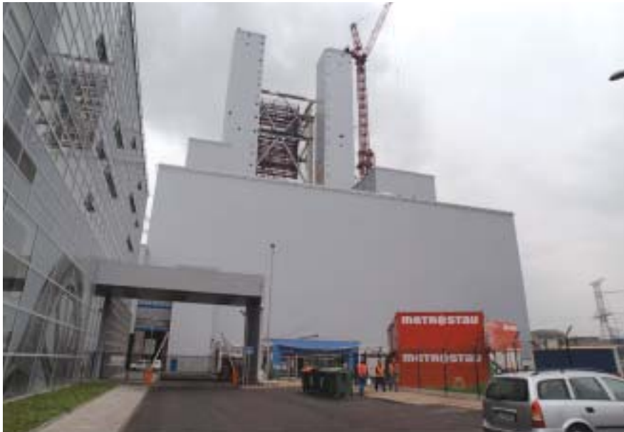
Aktuální fotografie budov hlavního výrobního bloku
