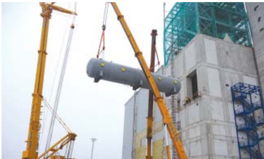
Obrázek zvedání napájecí nádrže dvěma mobilními jeřáby
