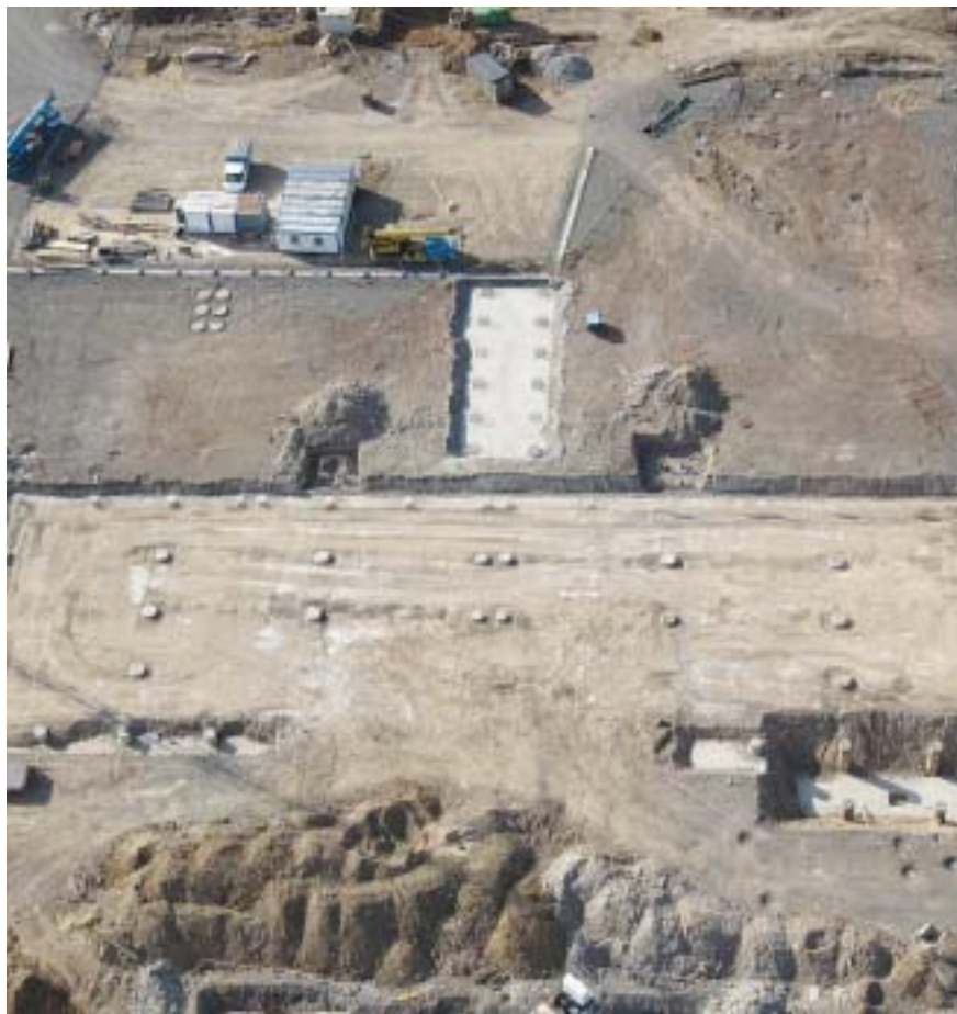
Fotografie provádění základových konstrukcí elektroodlučovače a kouřového ventilátoru (piloty a základové desky)
