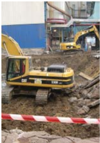
Před zahájením vlastní výstavby bylo nutno realizovat zemní práce
