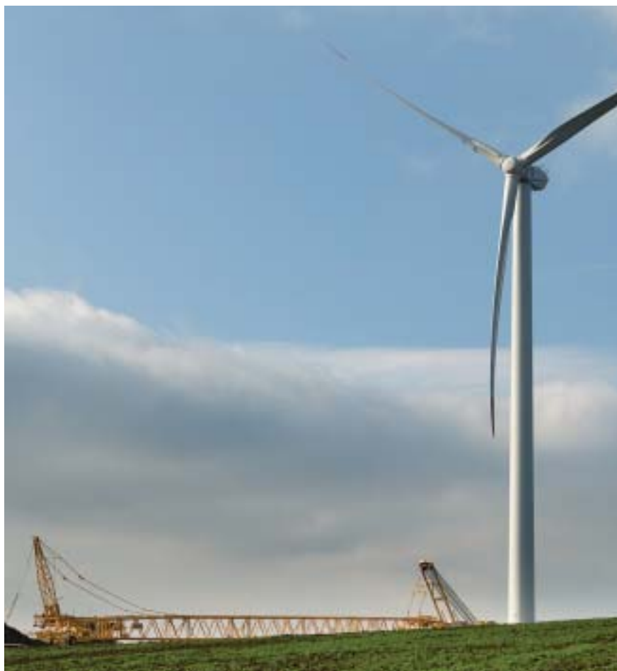
Demontáž jeřábu po montáži větrné elektrárny
