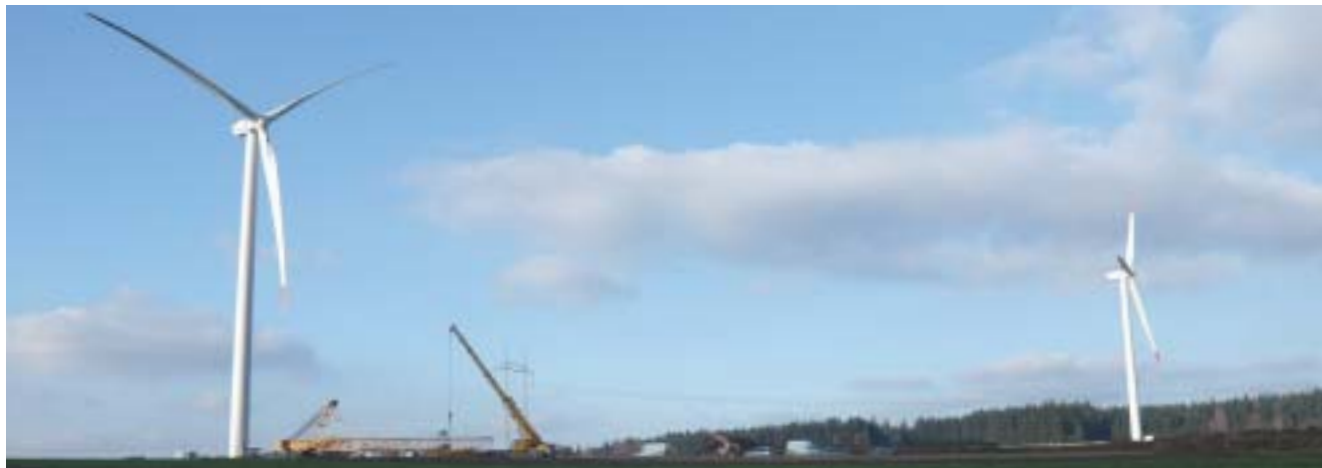
Montáž technologií začala 23. října 2009
