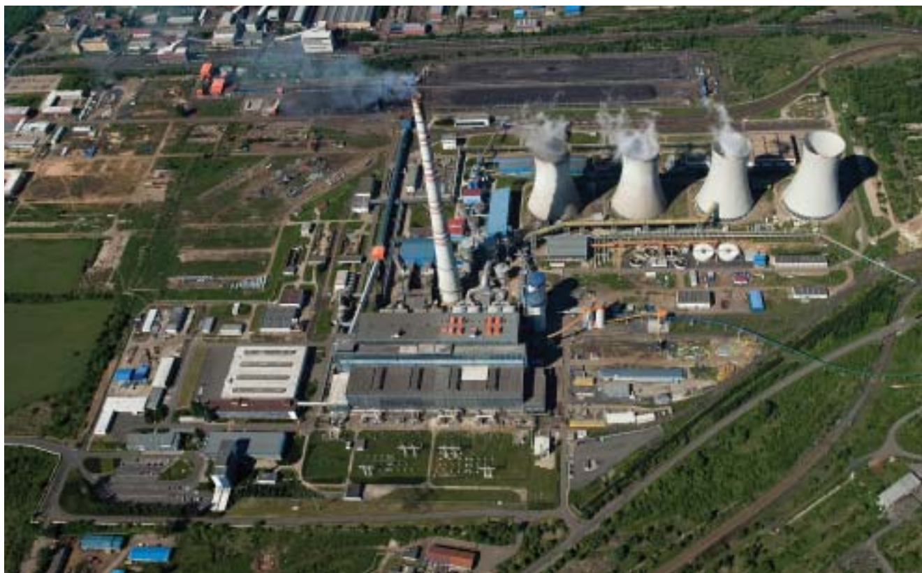
Letecký snímek Elektrárny Tušimice II
