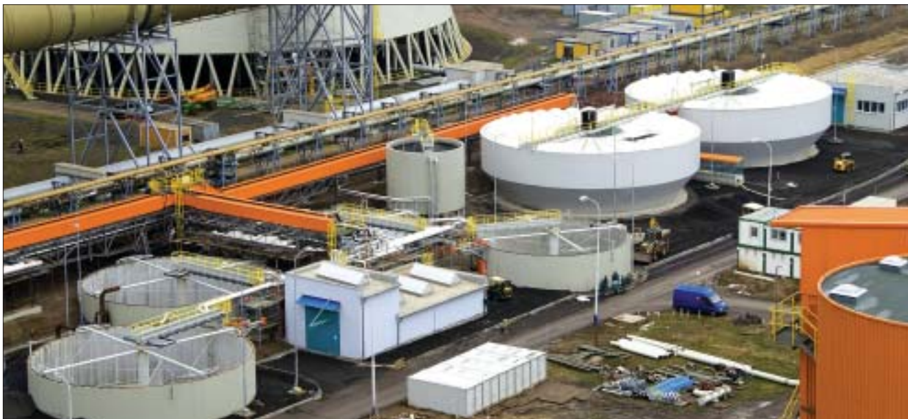
Pohled na vodní hospodářství
