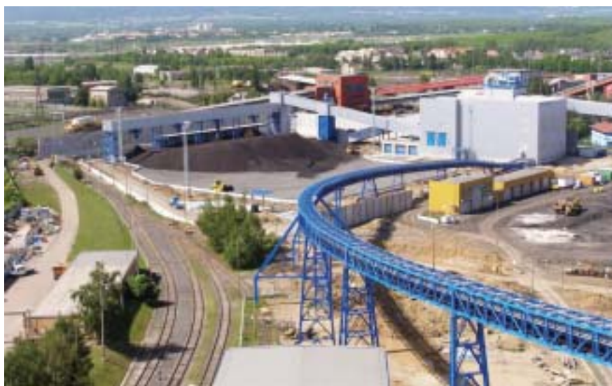
Pohled na novou skládku uhlí včetně technologie drtírný a zuhlování stávajících bloků elektrárny
