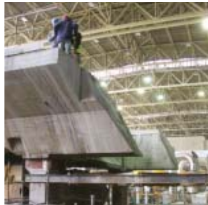
Zbytek původního základu před napojením na novou část
