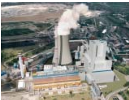
Obr. 3 – Areál Elektrárny Ledvice s vizualizací nového bloku po rekonstrukci
