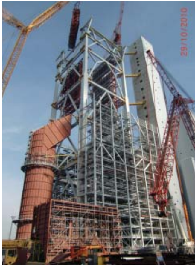
Momentky z montáže ocelových konstrukcí kotle
