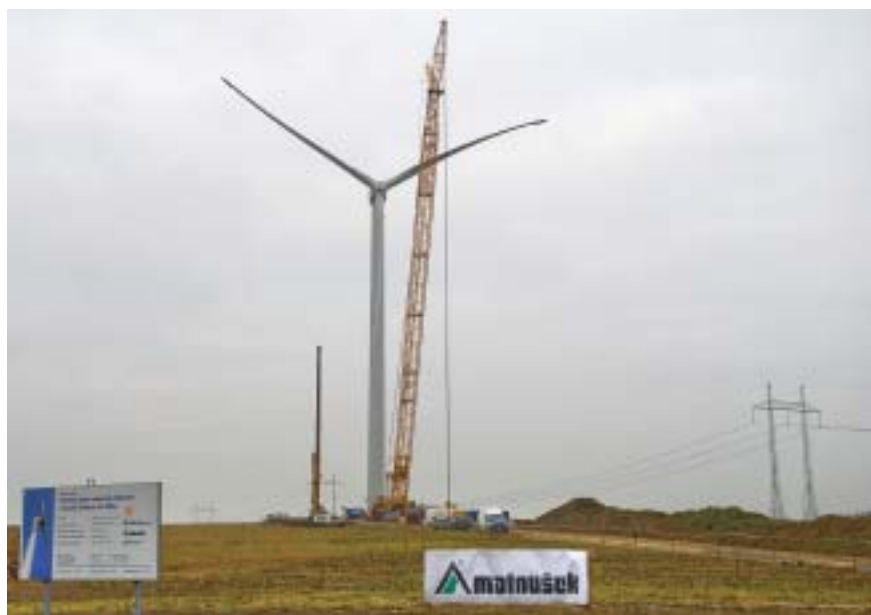
Snímek z montáže částí větrné elektrárny
