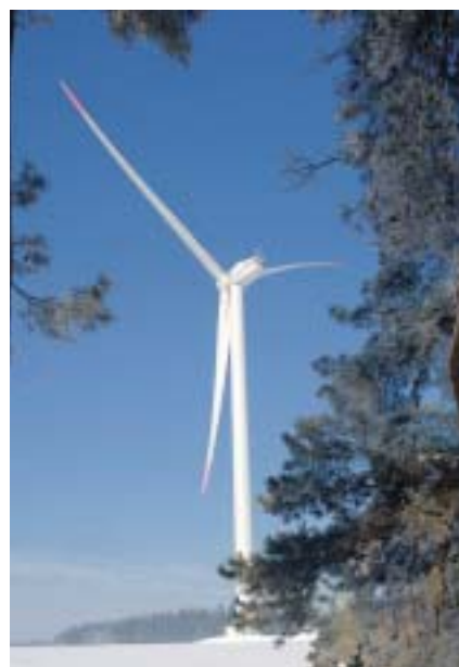
Větrná elektrárna u Věžnice v provozu
