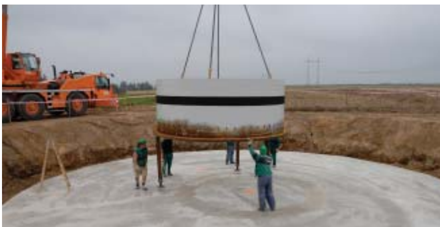
Usazení základového dílu
