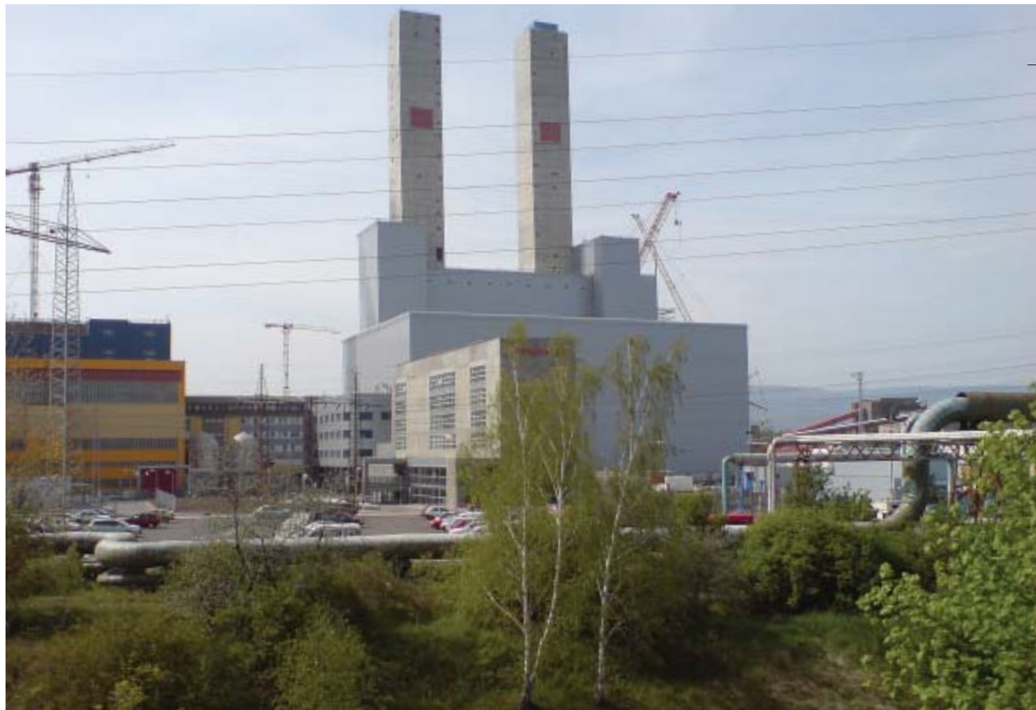
Obr. 1 – Přesypné věže a koridor nad strojovnou
