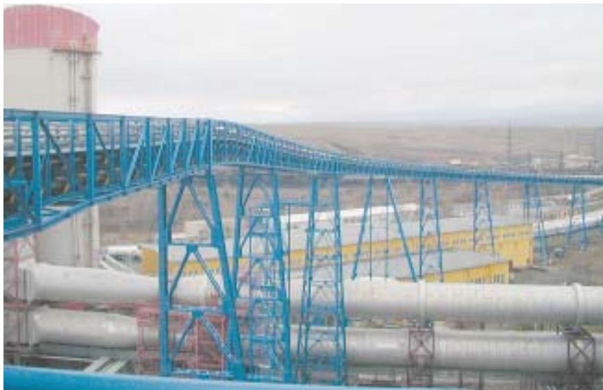
Dopravník T6 A/B: Pohled ze stávající kotelny
