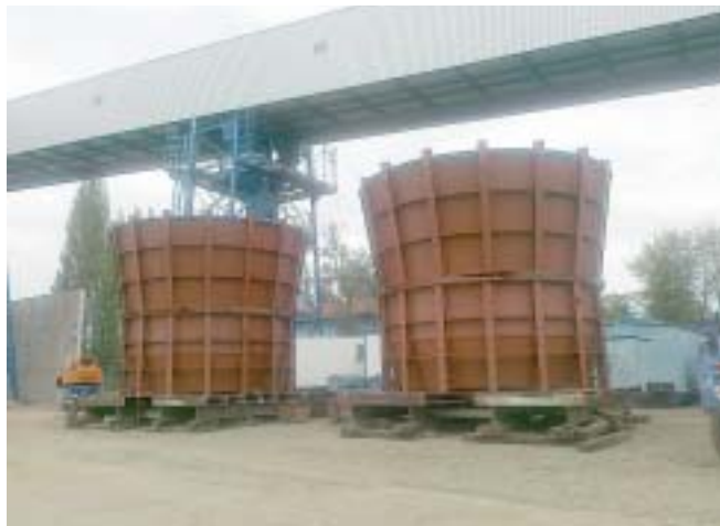
Vnitřní ocelové části vynášecího zařízení Extromat – svařování dílů na stavbě
