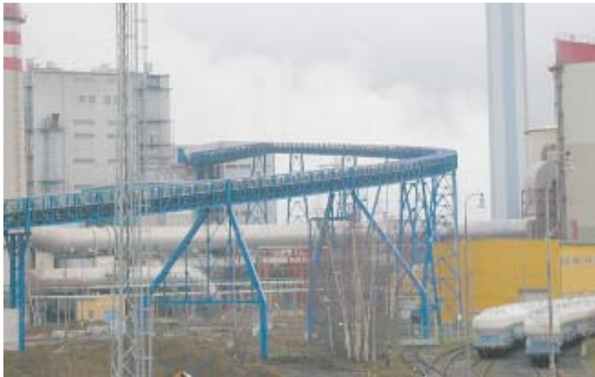
Dopravník T6 A/B: pohled ze skládky uhlí
