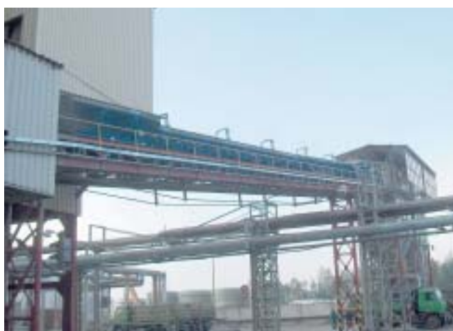
Trubkový dopravník na stávajícím mostě
