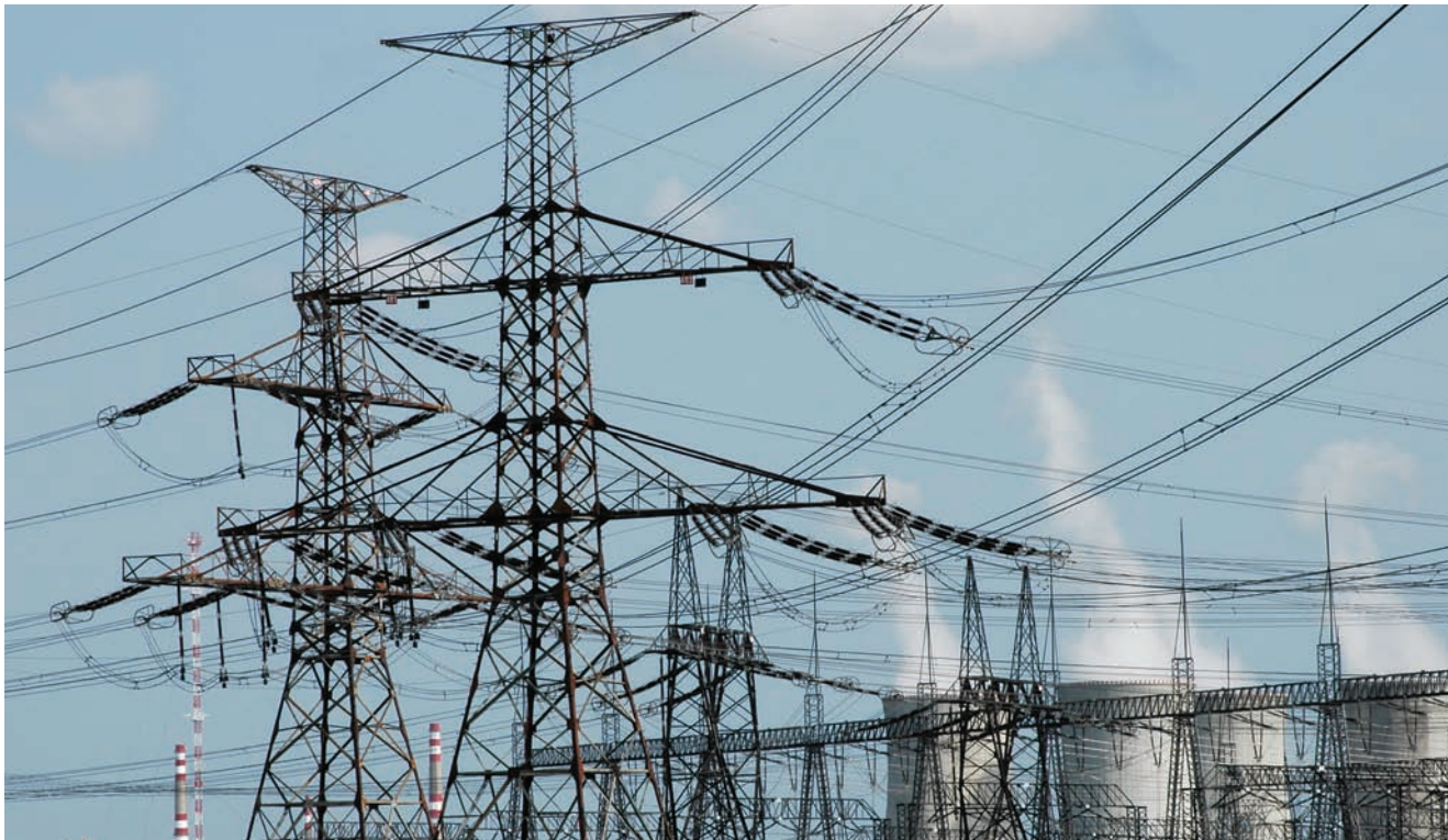
Ocelová příhradová konstrukce typu Donau
