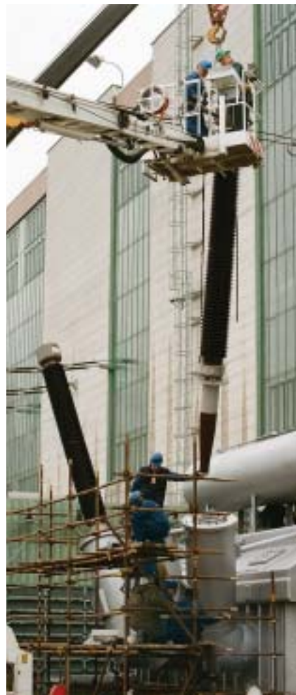
Montáž průchodek vn 420 kV nového blokového transformátoru 300 MVA za pomoci jeřábu, plošiny a speciálních přípravků
