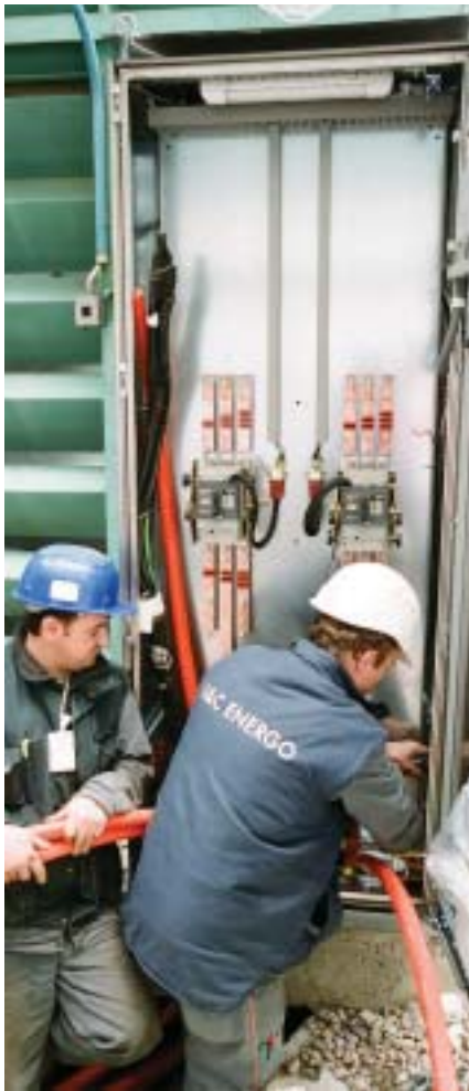
Montáž kabelů v GT skříních
