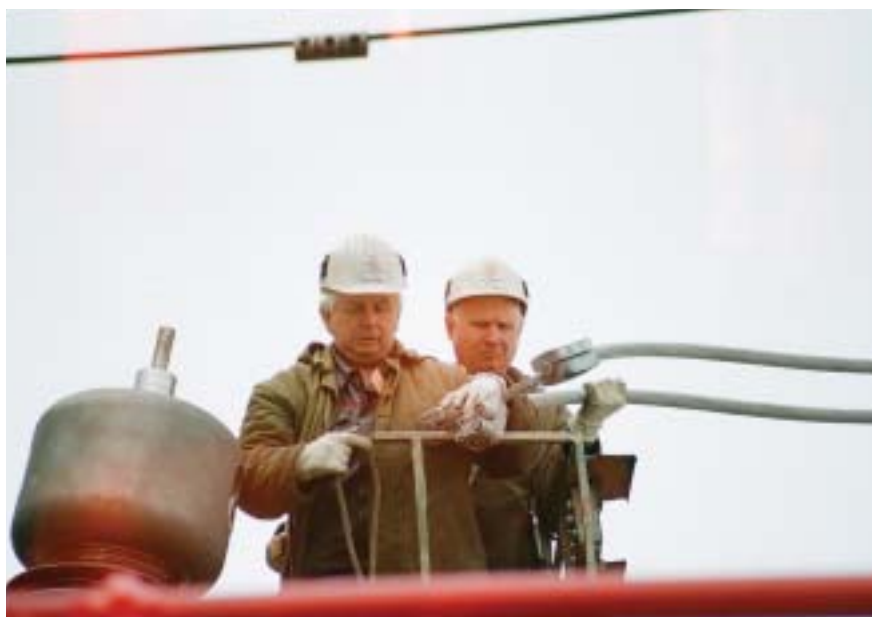
Připojování „klesačky“ vedení 420 kV k průchodce nového blokového transformátoru
