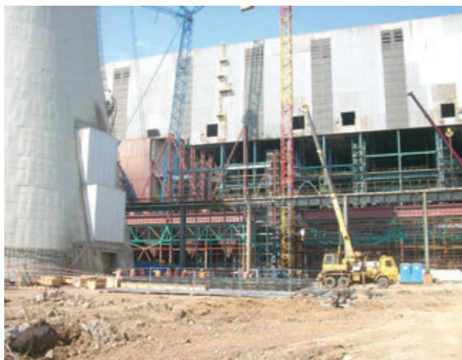
Obr. 7 – Elektrostatické odlučovače 23 a 24, montáž výsypek (duben 2013)
