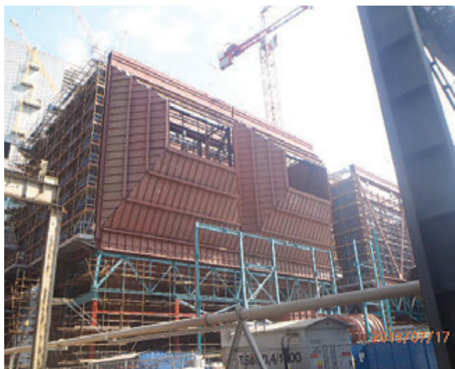
Obr. 9 – Odlučovače 23 a 24, montáž vnitřních ráků, izolace (červenec 2013)
