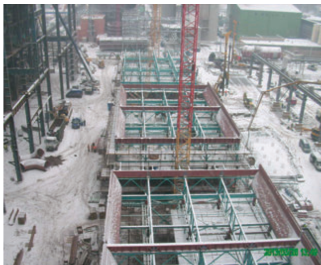
Obr. 6 – Odlučovače 23, 24 a 25, montáž roštů a ráků (březen 2013)
