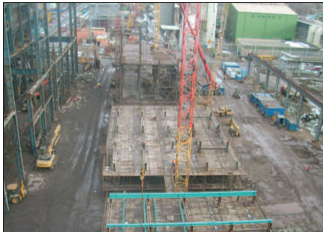
Obr. 4 – Odlučovače 23 a 24. Zahájení montáže roštu po demontáži (únor 2013)
