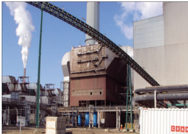
Obr. 3 – Stav před zahájením demontážních prací (odlučovač 25)
