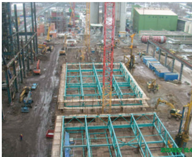
Obr. 5 – Odlučovače 23 a 24, montáž roštů (únor 2013)
