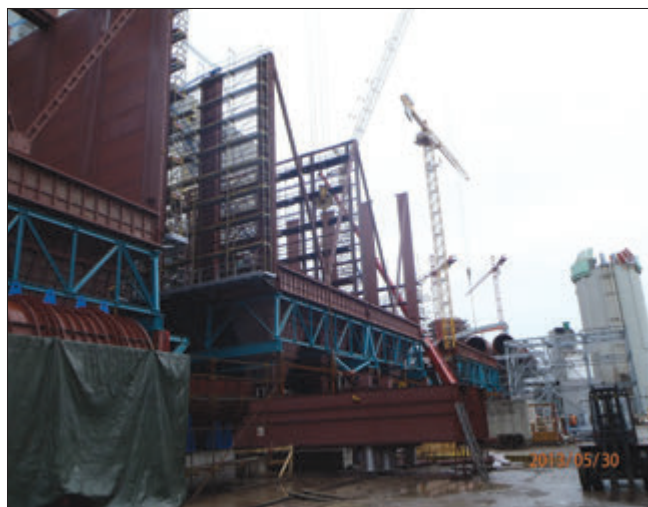
Obr. 8 – Odlučovače 23 a 24, montáž skříně a sloupů odlučovačů (květen 2013)
