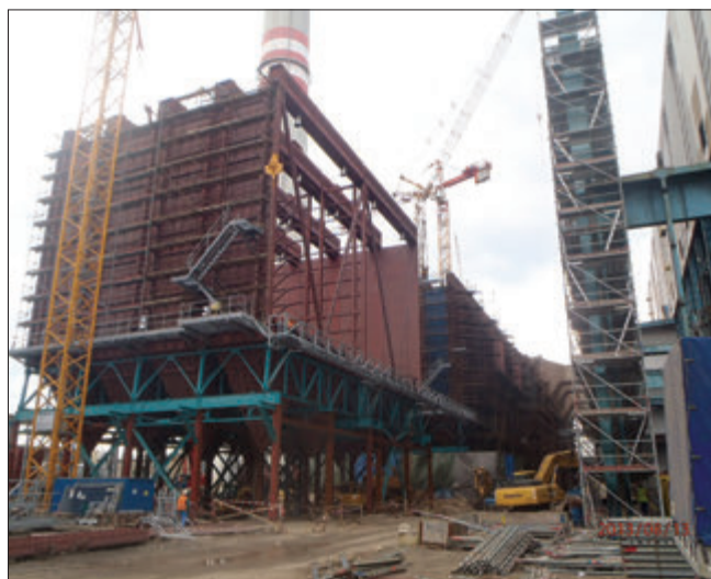
Obr. 10 – Elektrostatický odlučovač 25, montáž horních nosníků (srpen 2013)
