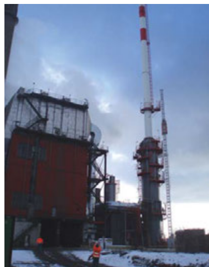
Obr. 6 – Pohled na absorbér a komínovou nástavbu (4. 2. 2015)
