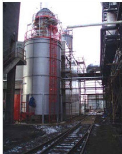
Obr. 8 – Pohled na objekt odsíření, vpředu havarijní nádrž (4. 2. 2015)
