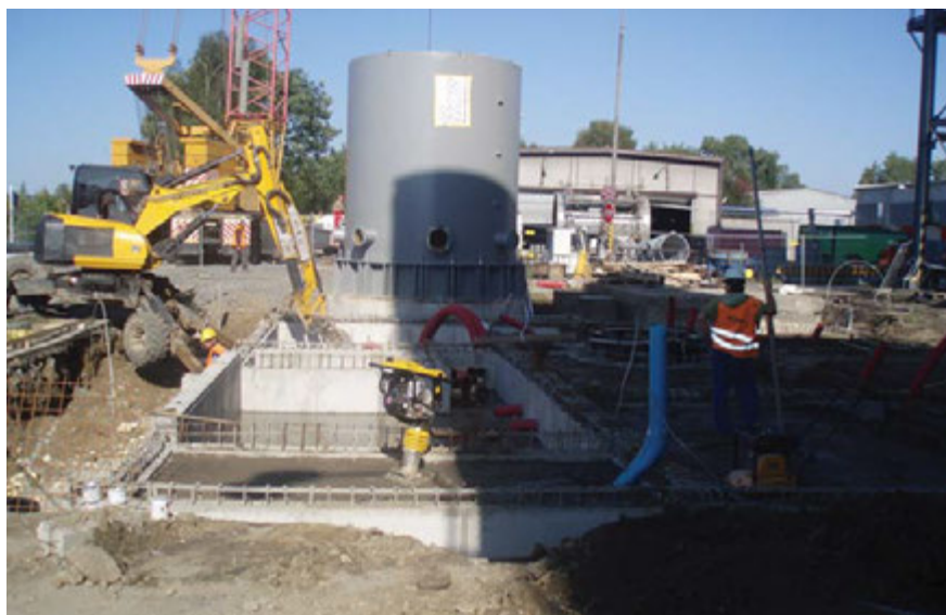
Obr. 4 – Ukotvení I. montážní dílu absorberu, souběžně probíhající základové práce pod objektem odsíření (17. 9. 2014)
