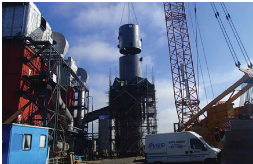
Obr. 5 – Montáž IV. dílu absorberu (29. 9. 2014)
