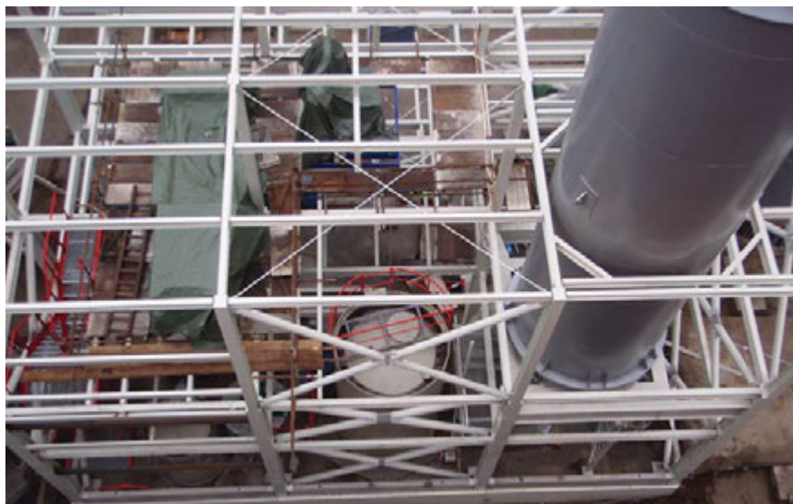
Obr. 7 – Pohled na objekt odsíření, nádrž provozní vody, silo vápence (20. 11. 2014)
