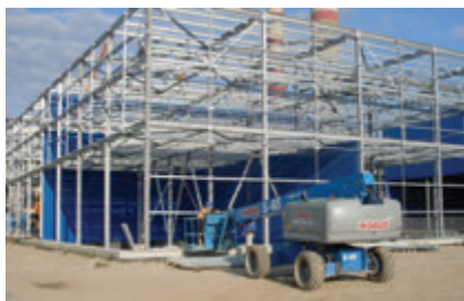
Ocelová konstrukce chladicí věže energetického centra společnosti SLOVNAFT, a.s.
