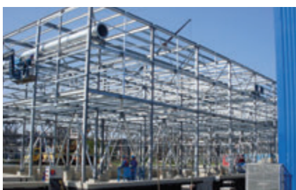
Ocelová konstrukce chladicí věže energetického centra společnosti SLOVNAFT, a.s.
