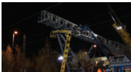
Potrubní most v elektrárně Prunéřov a jeho noční montáž
