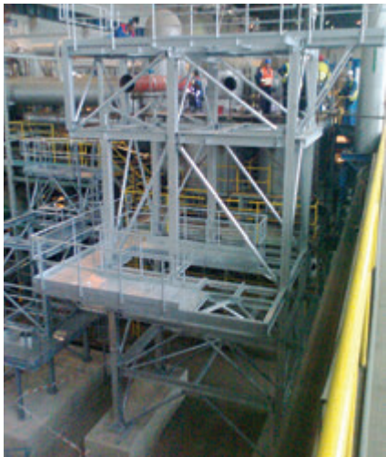
Obslužná ocelová konstrukce a potrubní most v elektrárně Mělník
