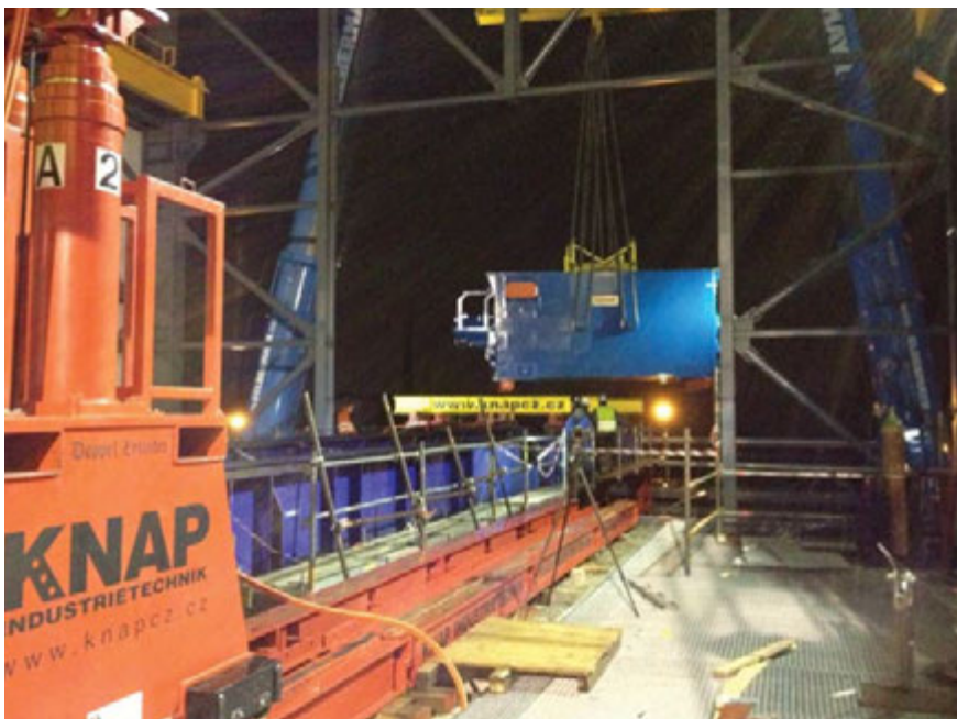
Zvedání generátoru dvěma 500tunovými mobilními jeřáby
