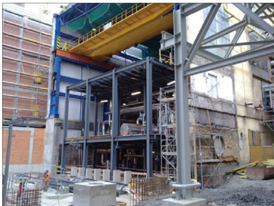
Opravená část strojovny s novou ocelovou konstrukcí pro novou výměňkovou stanici
