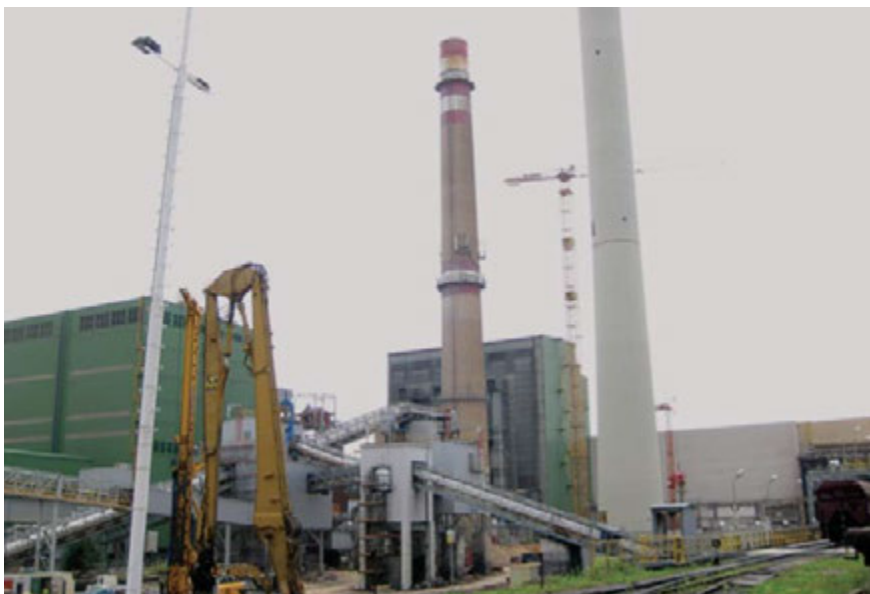
Nový komín ve výstavbě
