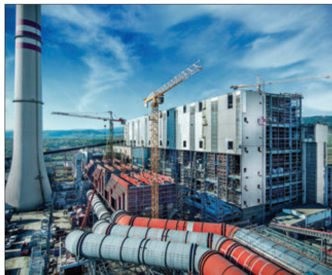
Pohled na hlavní výrobní blok během výstavby
