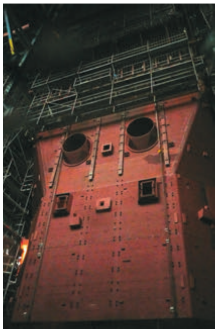
Obr. 6 – Pohled na montáž výparníku spalovací komory
