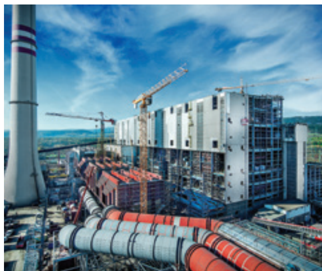
Rys. 2 - Widok na główny blok energetyczny w trakcie budowy
