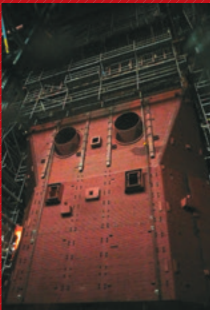
Rys. 6 - Widok na montaż parownika komory spalania
