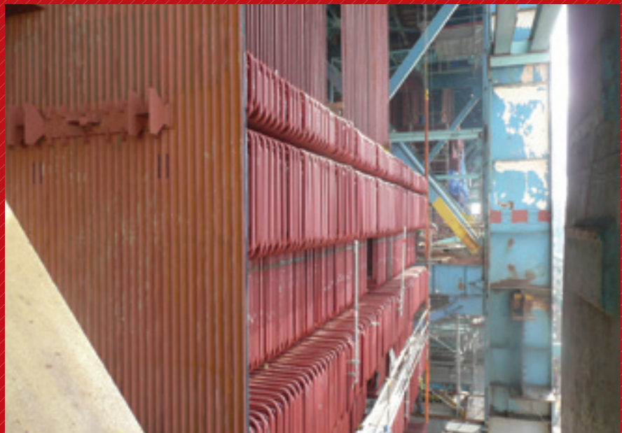
Rys. 7 - Widok na montaż tylnego ciągu kotła
