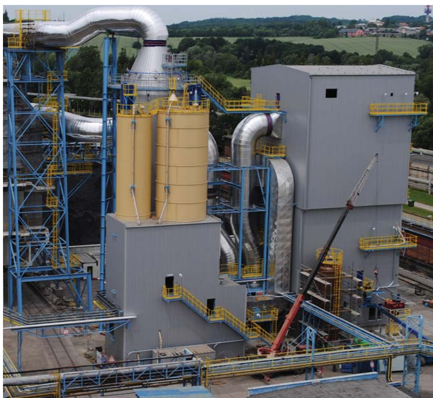
Odsíření kotlů K14, K13 a K12 - na snímku přípravné práce před výstavbou vlastního zařízení pro odsíření
