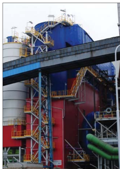
Objekt odsíření kotlů K2, K3 a K4 v Teplárně Karviná
