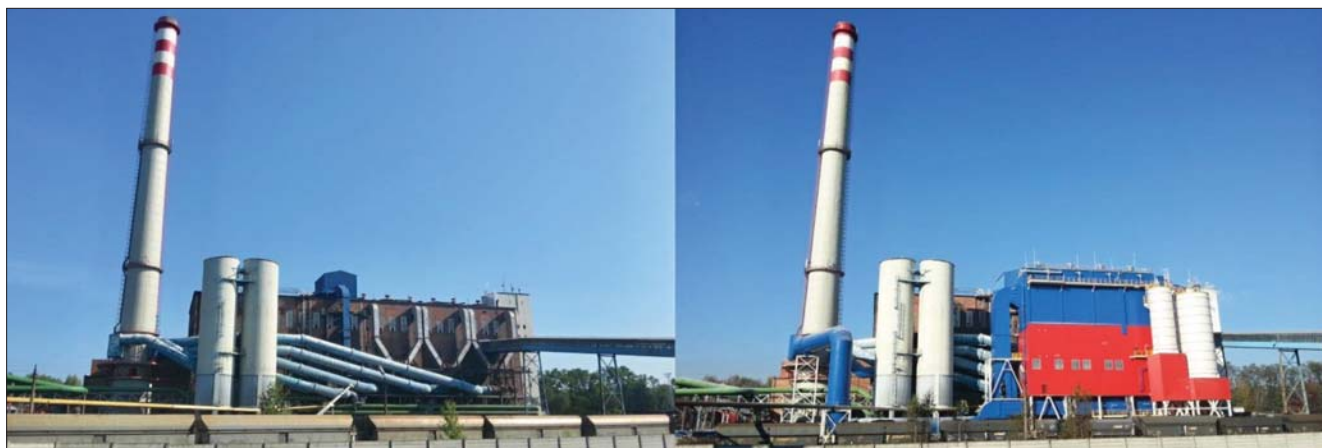
Pohled na Teplárnu Karviná - stav před a po instalaci odsíření
