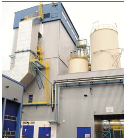
Budova s technologií odsíření kotlů K3 a K4 v Elektrárně Třebovice
