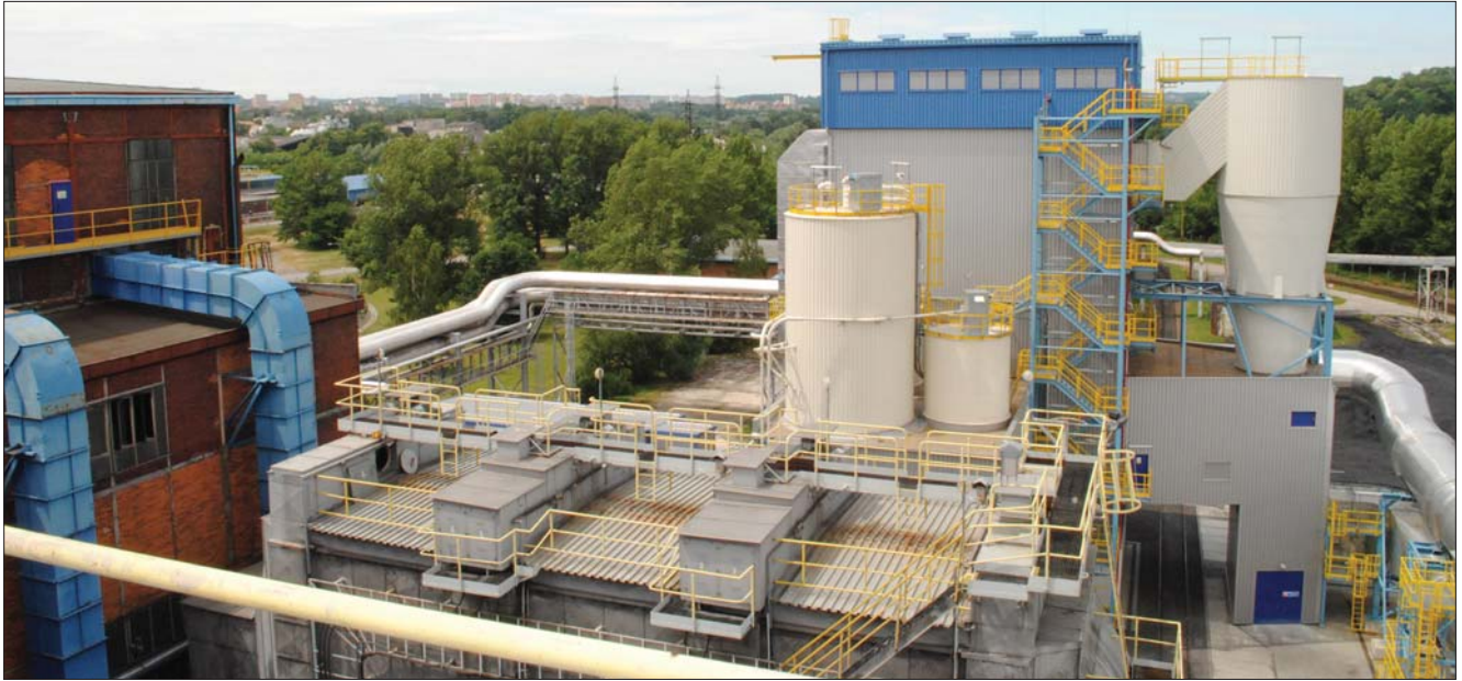
Pohled na nové odsíření elektrárny Třebovice
