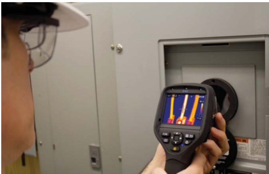
Obr. 13 – Technik provádějící monitorování elektrických instalací termokamerou. Kontrola je zde prováděna skrz tzv. IČ okénko, které je propustné pro infračervené záření. Odpadá tak nutnost otevírání rozvodné skříňe z důvodu kontroly
