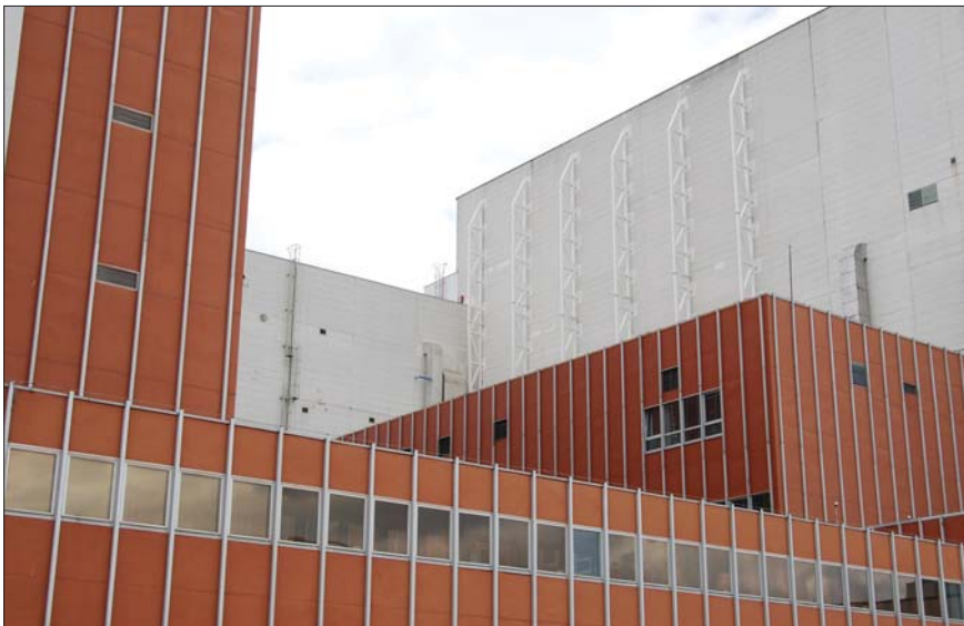
Zodolněný objekt reaktorovny (ocelové konstrukce na boční stěně)
