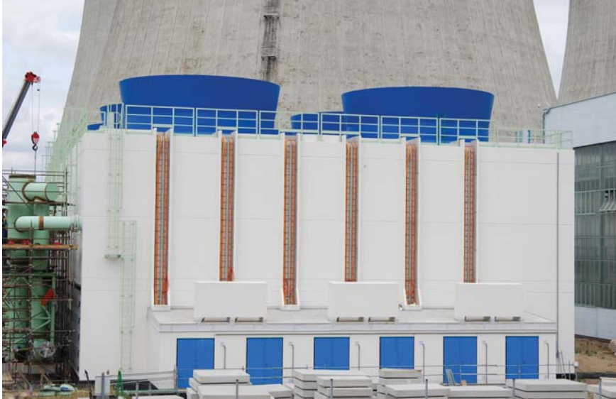
Koncový jímač tepla - ventilátorové věže
