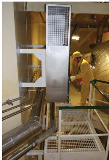
Na snímku rekombinátory vodíku s obsluhou
