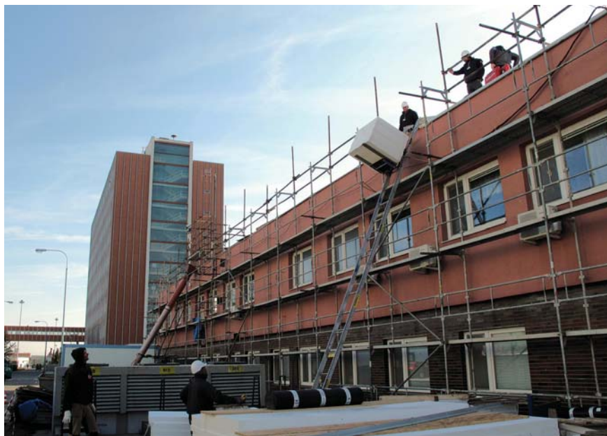
Práce na zodolnění budovy Hasičského záchranného sboru při Jaderné elektrárně Dukovany
