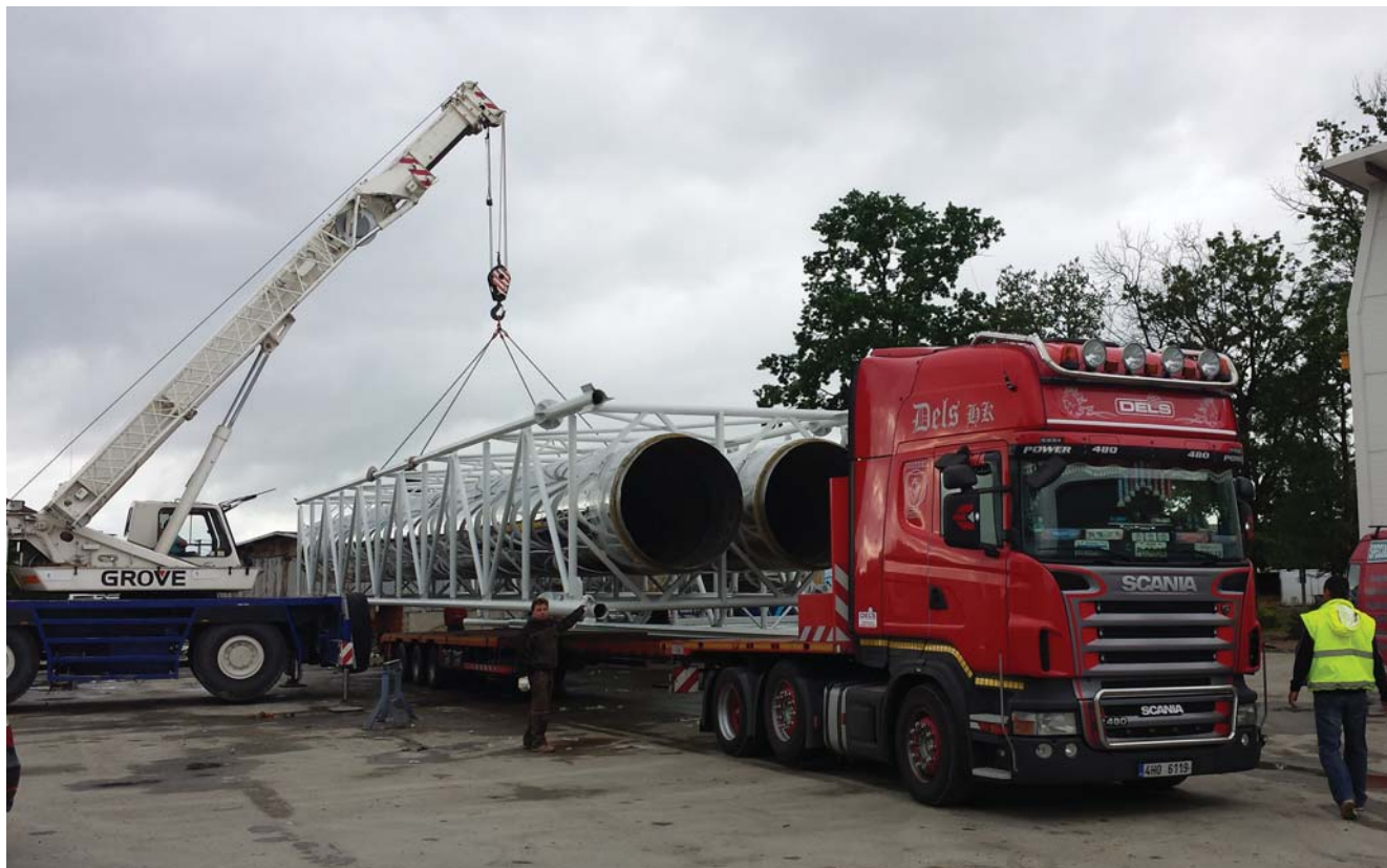
Nakládka konstrukcí na auto
