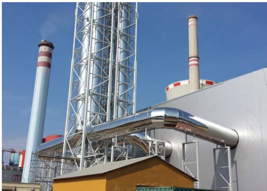
Napojení kouřovodu z kotelny do komína
