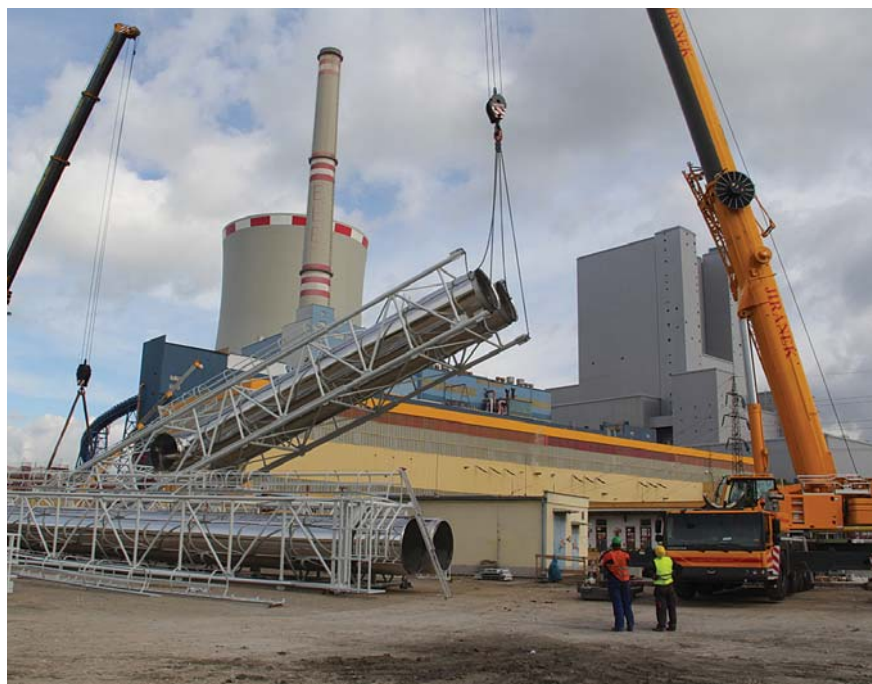
Proces vztyčování první části komína
