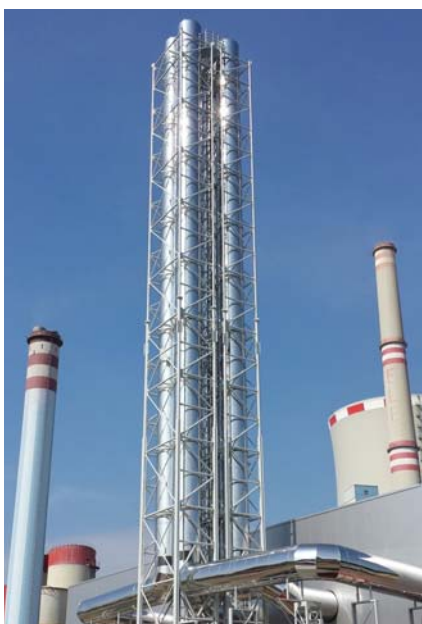
Celkový pohled na komín
