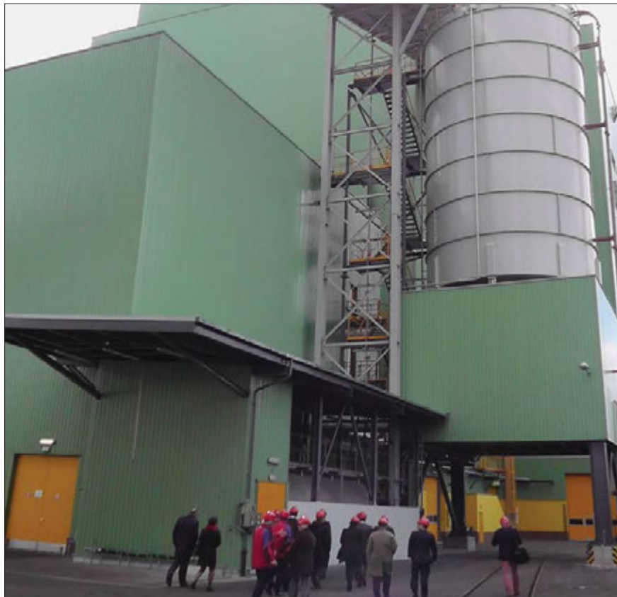
Vápcové silo a budova ventilátorů
