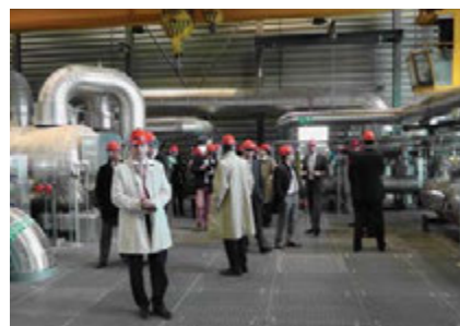
Momentka z exkurze v provozu nového kotle K7
