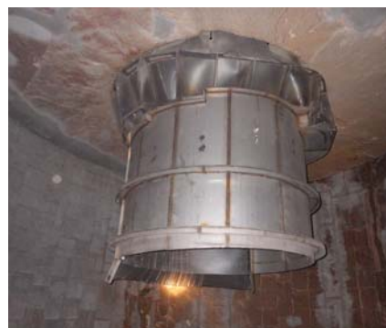
Druhá provizorní oprava, během níž byla doplněna chybějící válcová část na plášti zařízení
