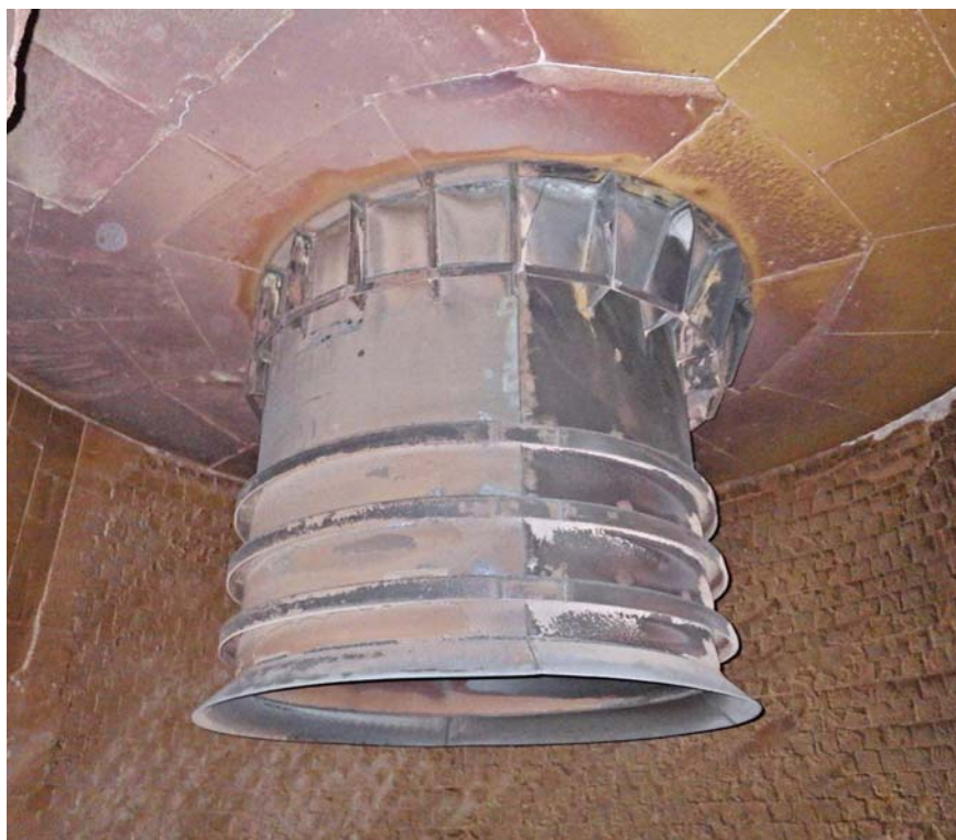
Vortex po roce provozu od provedení konstrukčních opatření
