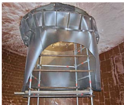
První provizorní oprava, během které došlo k vyříznutí zdeformované části vortexu a následnému zpevnění ocelovou vzpěrou
