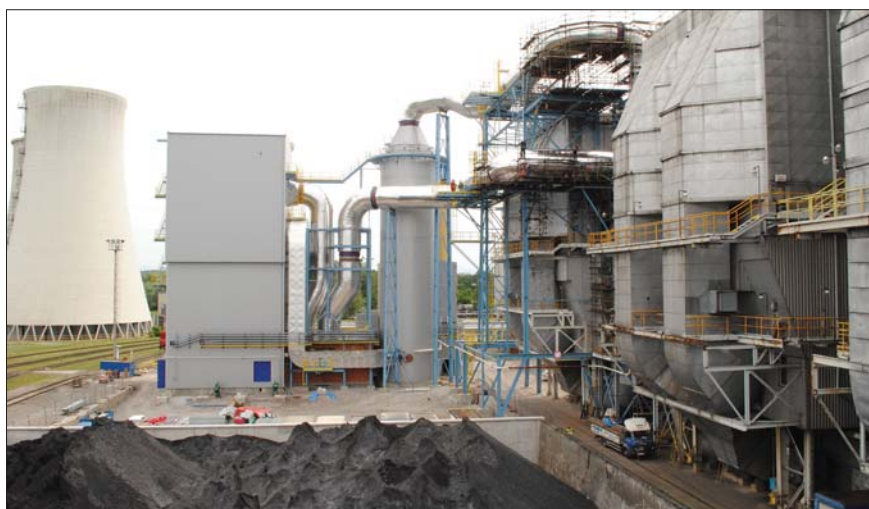
Uprostřed nové ekologické technologie, vpravo stávající elektroodlučovače
