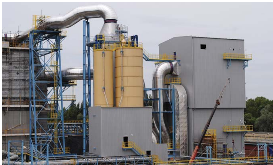
Snímek z výstavby zařízení pro odsíření v Elektrárně Třebovice
