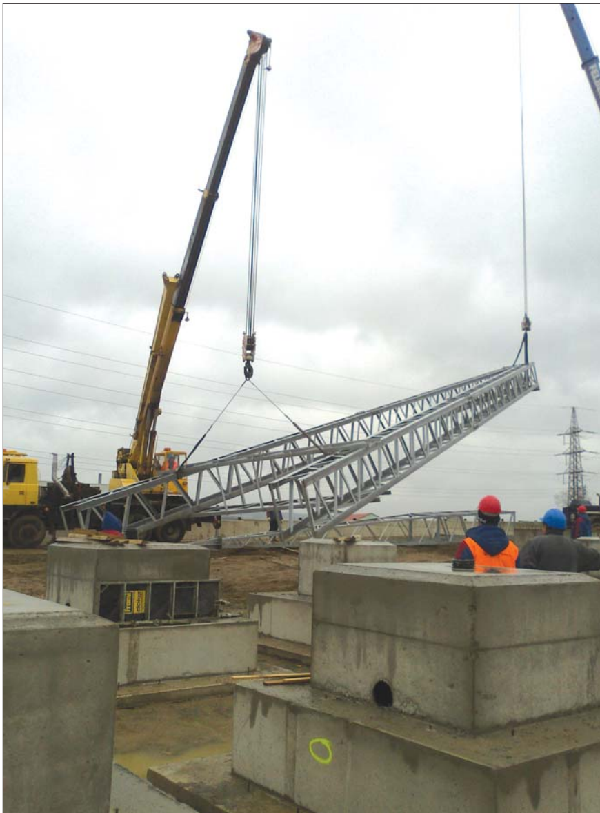
Momentka ze vztyčování ocelové konstrukce stožáru
