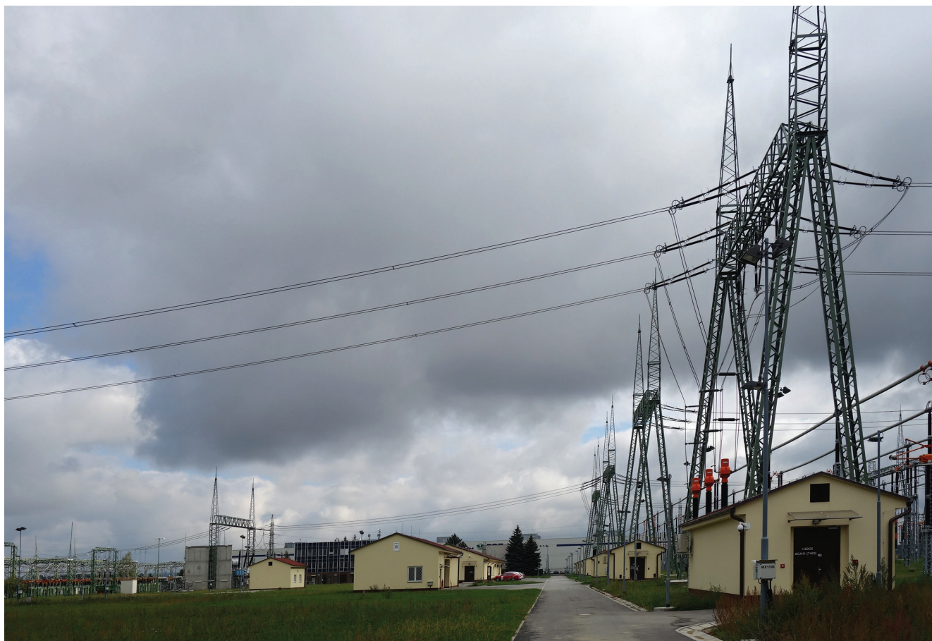
Celkový pohled na rekonstruovanou část (centrální domek, domky sekundární techniky)
