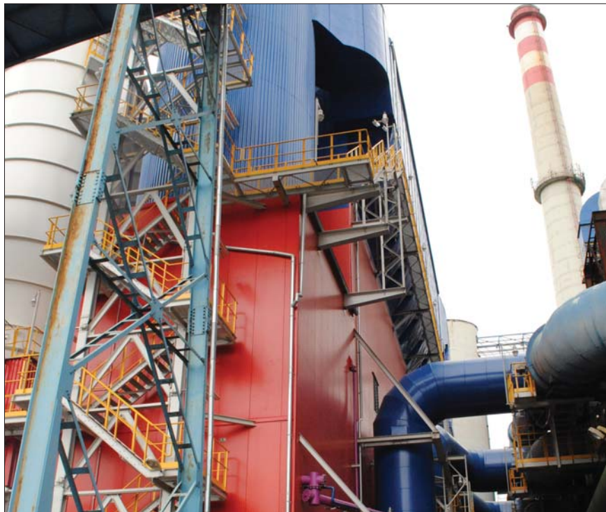
Objekt odsíření je vysoký 38 metrů. Vpravo komín, který byl vyvložkován
