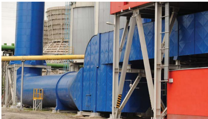
Pohled na část objektu pro odsíření v Teplárně Karviná
