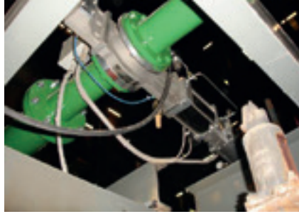
Fot. 2 - Instalacja zasowy szybkoocinającej DN 125 z detekcją na rurociągu transportu pneumatycznego do kotła FK2.
