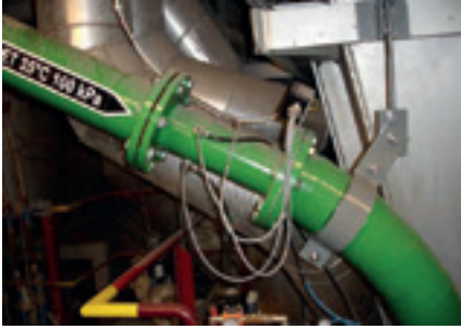
Fot. 2 - Instalacja zasowy szybkoocinającej DN 125 z detekcją na rurociągu transportu pneumatycznego do kotła FK2.
