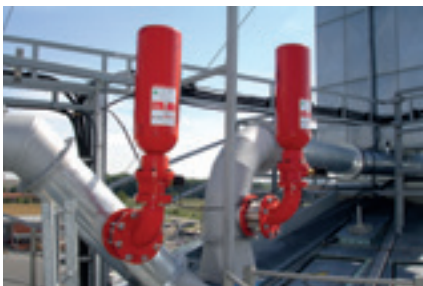
Fot. 4 - Instalacja izolacji wybuchu - bariery HRD na rurociągu wlotowym filtra.
