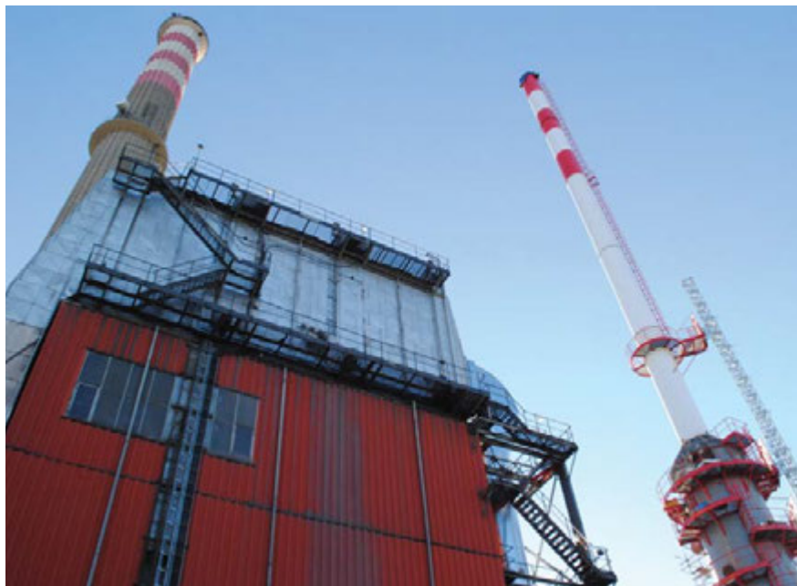
Pohled na teplárnu Planá nad Lužnicí - vlevo komín nového odsiřeni
