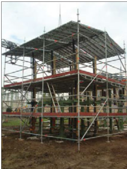
Lešení představuje dočasnou ocelovou konstrukci
