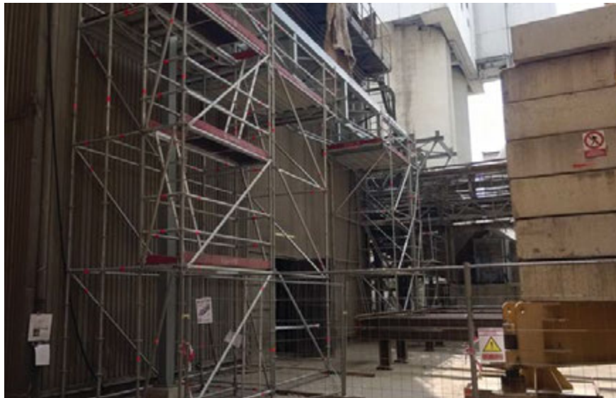
Lešení je stále častěji doplněno doplňujícími bezpečnostní prvky
