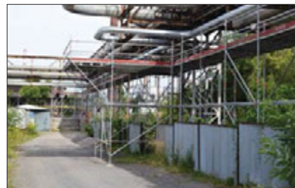
Ukázka lešení pod rozvody tepla a plynu
