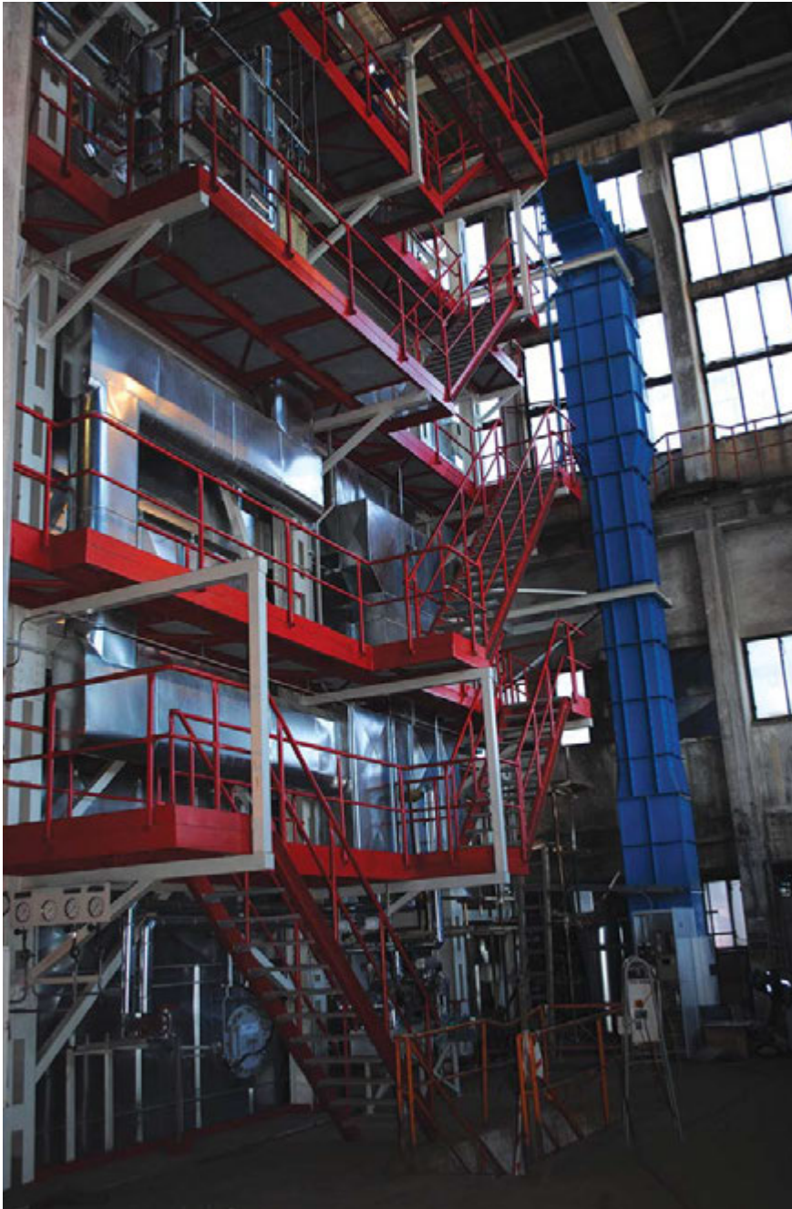
Nový kotel ve výstavbě
