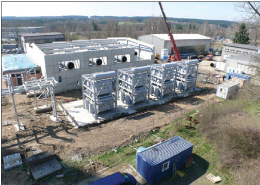
Pohled na smontované parogenerátory HRSG
