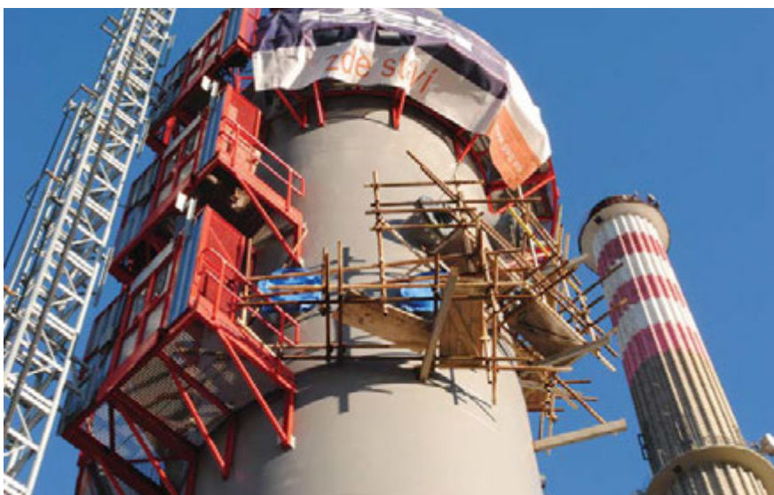
Snímek z výstavby odsíření (leden 2015)
