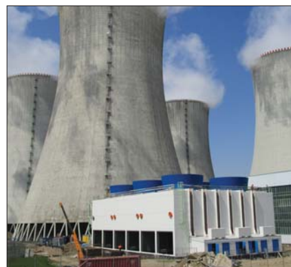
Pohled na objekt Koncového jímáče tepla
