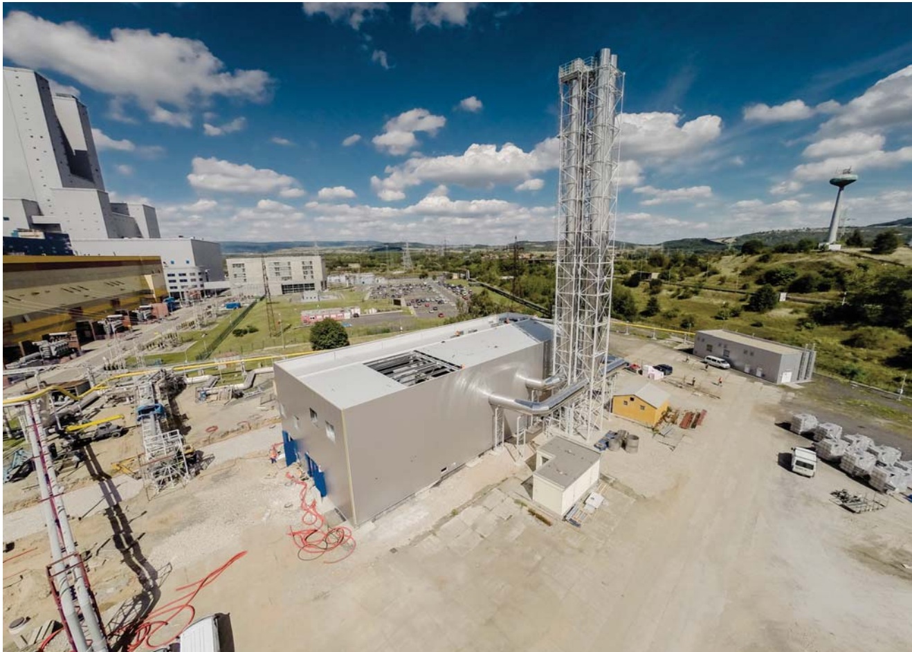
Na projektu výstavby kotelny v Elektrárně Ledvice se podílela i firma REKO PRAHA, a.s.
