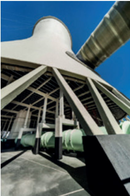
Rys. 3 - Widok nowej płyty dna chłodni kominowej i kanał pionowy wody ogrzanej
