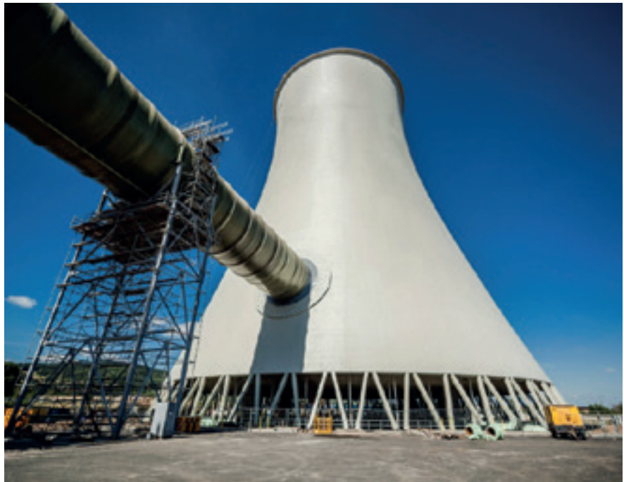
Rys. 4 - Płaszcz zewnętrzny chłodni kominowej po ukończeniu prac
