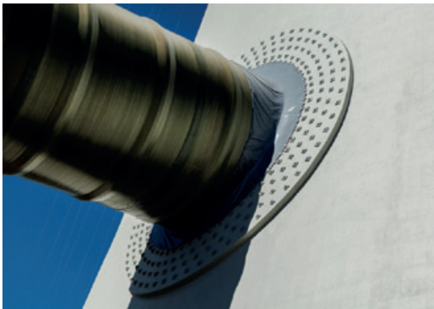
Rys. 5 – Przejście dla przewodu dymowego
