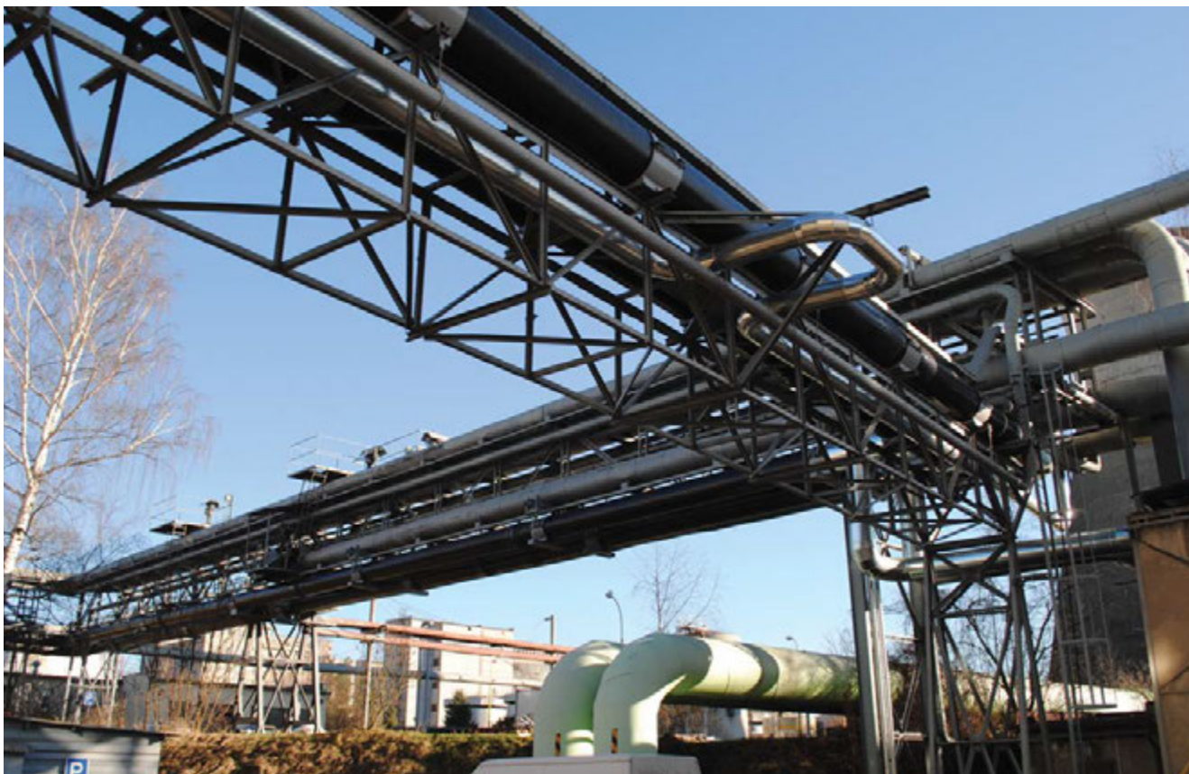
Nové teplovodní rozvody
