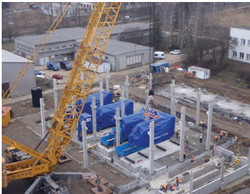
Únor 2014 - usazování motor-generátorů na pozice
