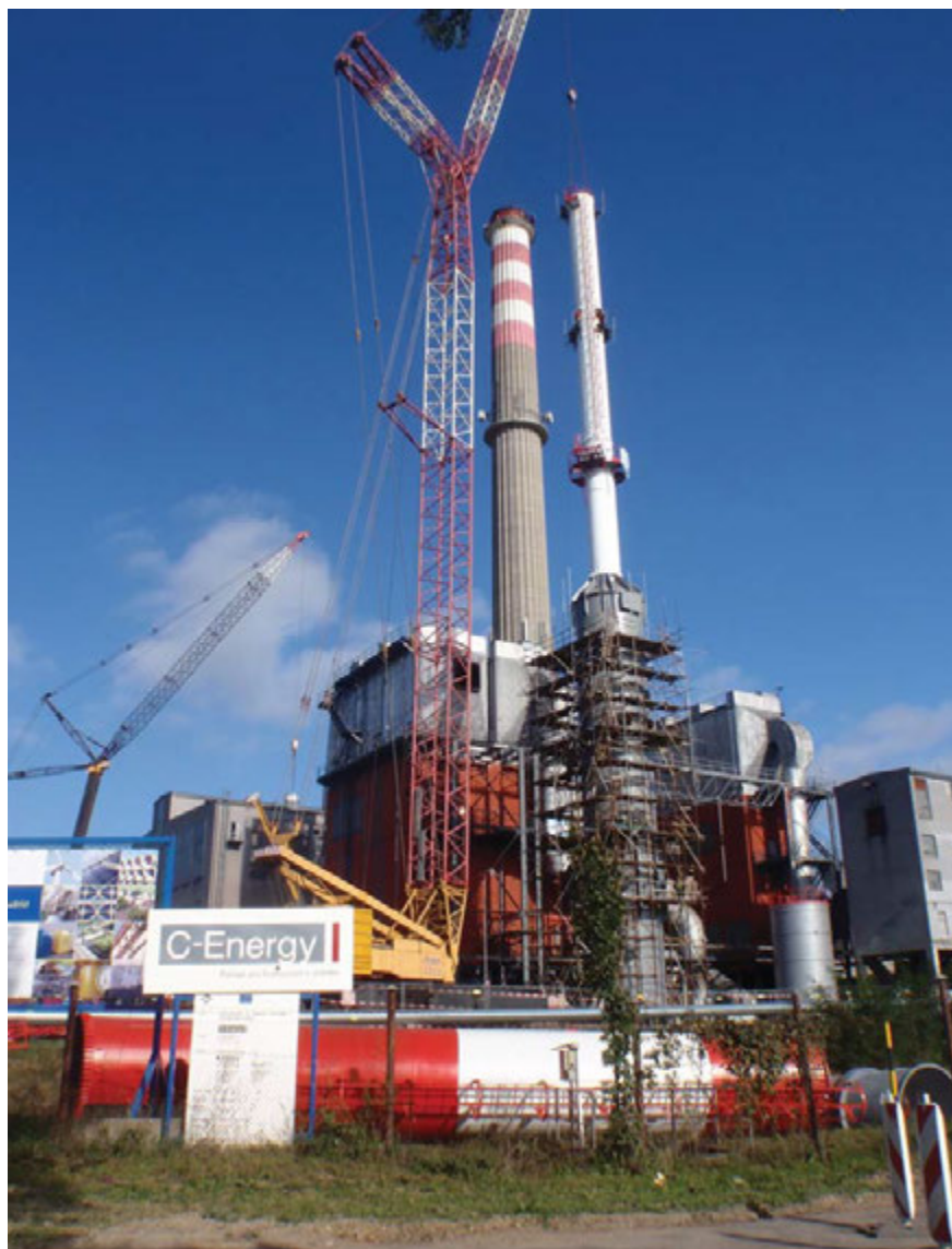
Odsíření kotlů se stává novou dominantou teplárny
