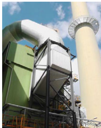
Pohled na část nového kotle
