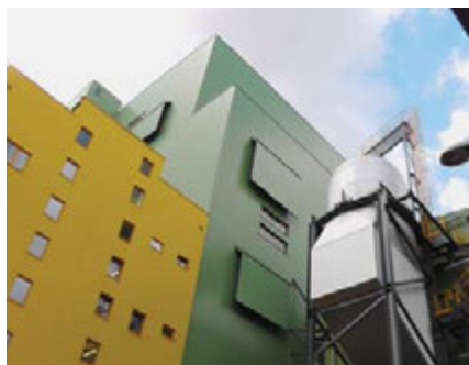
Pohled na nový kotel K7
