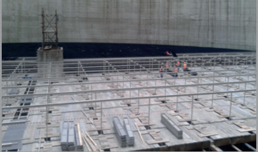
⚠️ Następnie kładzione są eliminatory, które na brzegach należy ściąć do łuku
