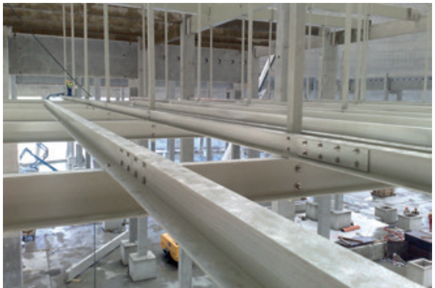
⚠️ Widok na potężną konstrukcję kompozytową w chłodni kominowej Počerady
